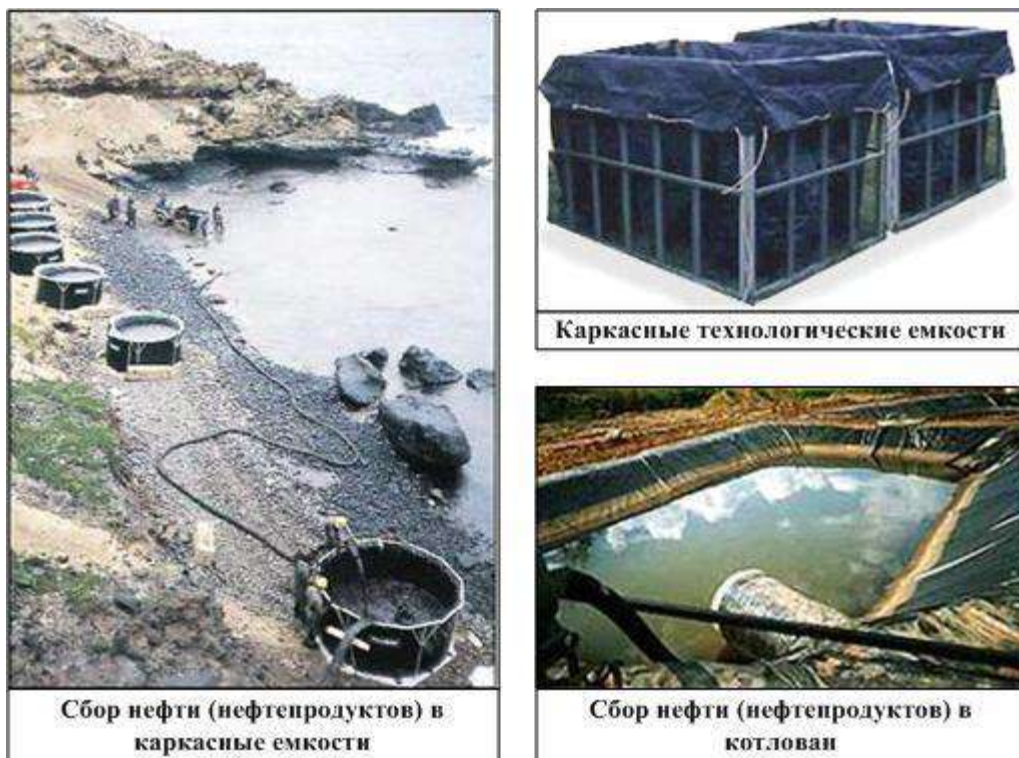
Рис.14. Организация сбора и временного хранения собранной нефти (нефтепродуктов)
