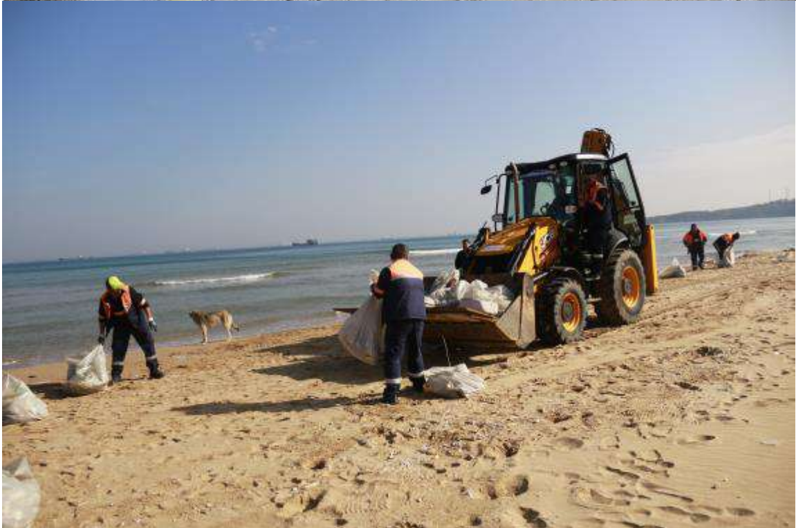
Рис.15. Сбор разлитой нефти (нефтепродуктов) с использованием ручного шанцевого инструмента
