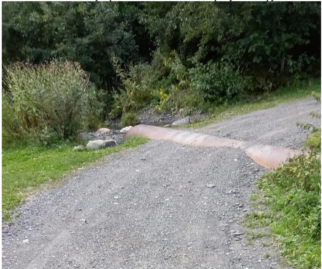
Фото 3. Водопропускная труба  $\varnothing$  100 см на переходе дороги
