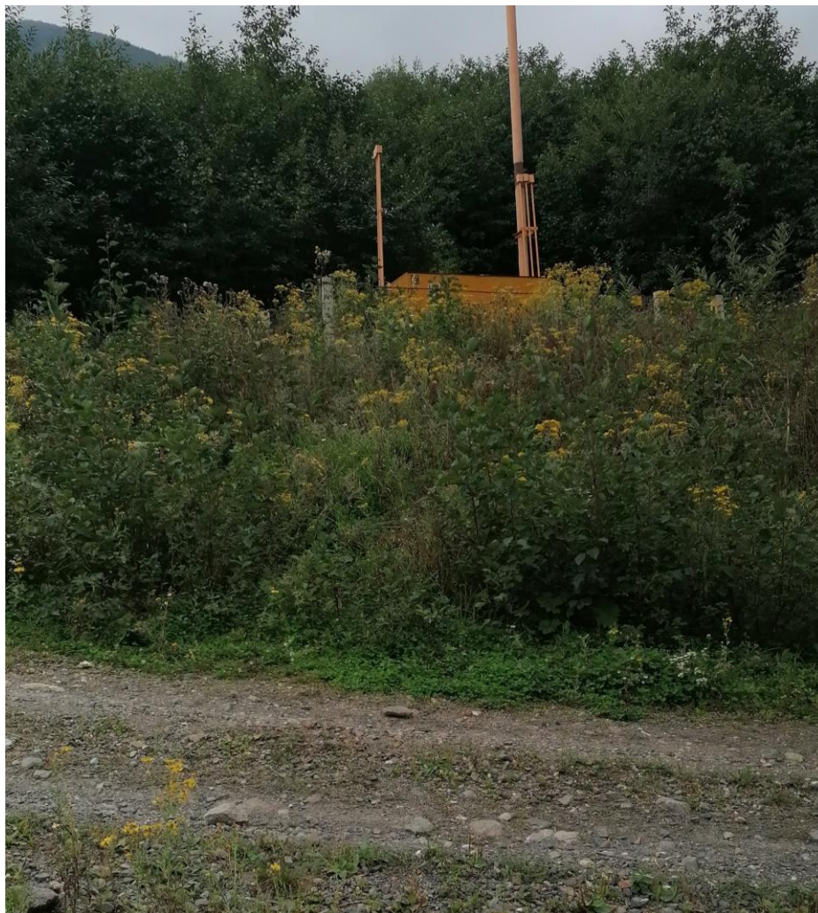
Фото 1. Начало трассы газопровода ПК0+0,00 (ГРС).
