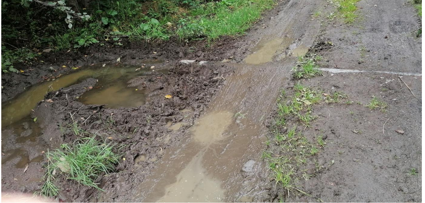
Фото 2. Водопропускная труба Ø 50 см. ПК 0+30,0-ПК 0+39.
