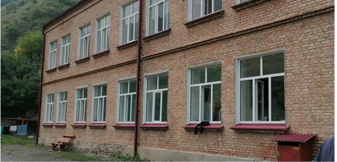
Фото 4. Конец трассы газопровода ПК 2+72 (Реабилитационный центр).
