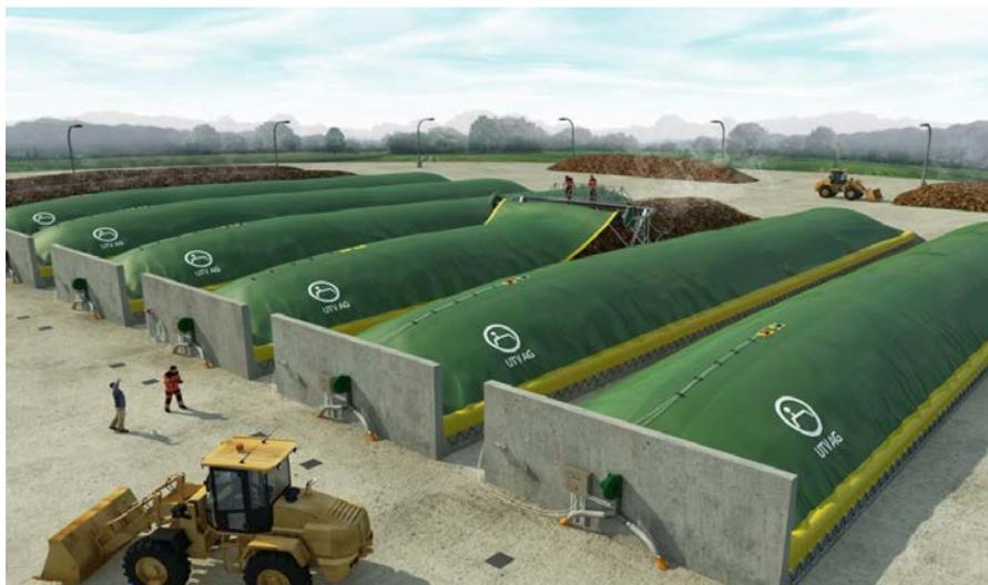
Рис. 2.4.7 – Вид ванны компостирования
