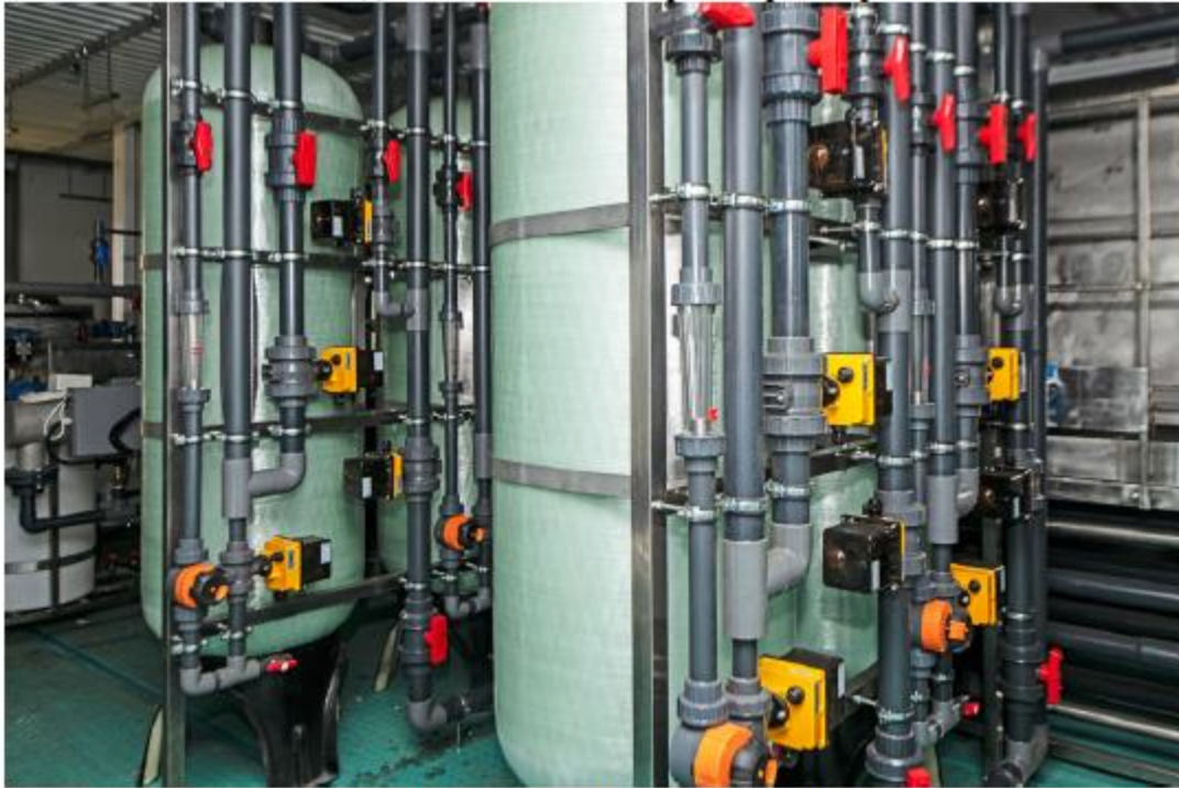
Рис.7 Установка напорных фильтров
