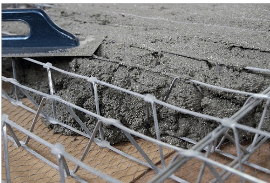
Рис. 18. Укладка жесткой бетонной смеси в опалубку
