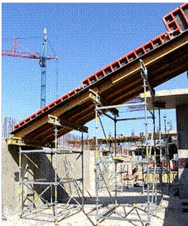
Рис.12. Собранная опалубка для наклонного перекрытия
