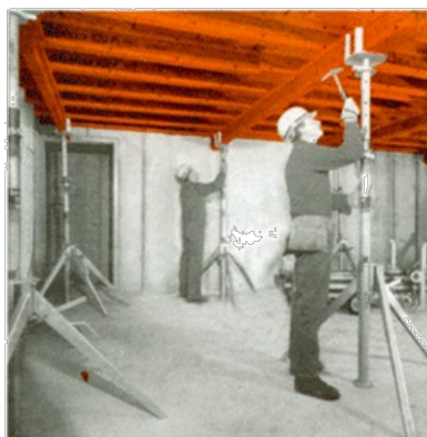
Рис. 19. Опускание нижних балок-ригелей
