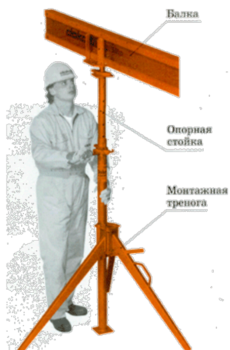
Рис.9. Выверка балок-ригелей по высоте
