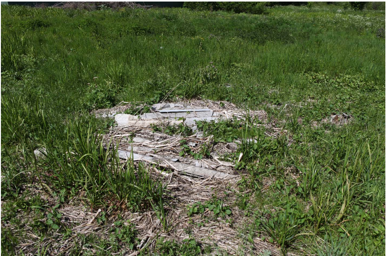
Фото 8. Свалка строительного мусора в районе полосы отвода КЛ
