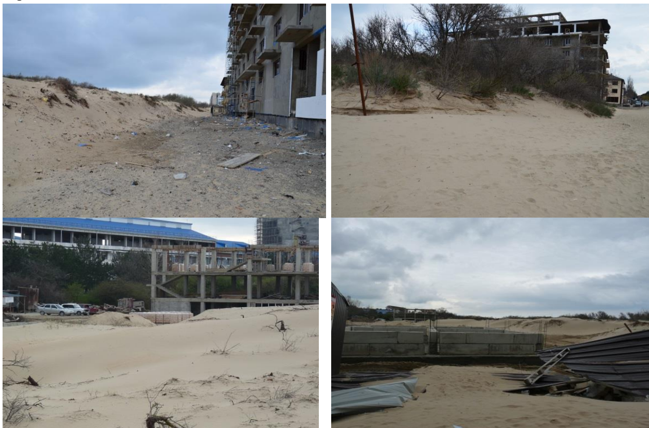
Рисунок 6.9 – Строительство капитальных зданий в непосредственной близости от песчаных дюн в зоне песчаных бугров
