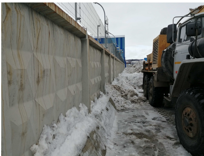
Рисунок 10 – Бетонный забор в юго-западной части участка изысканий
