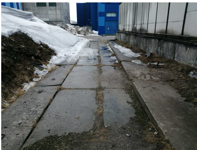
Рисунок 8 – Бетонное покрытие территории
