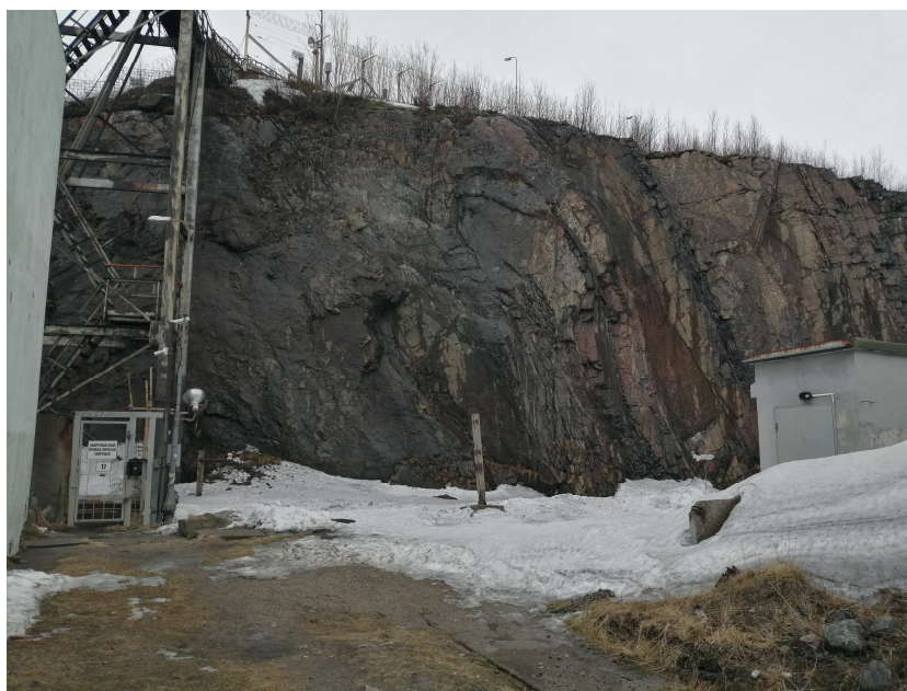
Рисунок 14 – Выход скального грунта на дневную поверхность. Точка наблюдения 1
