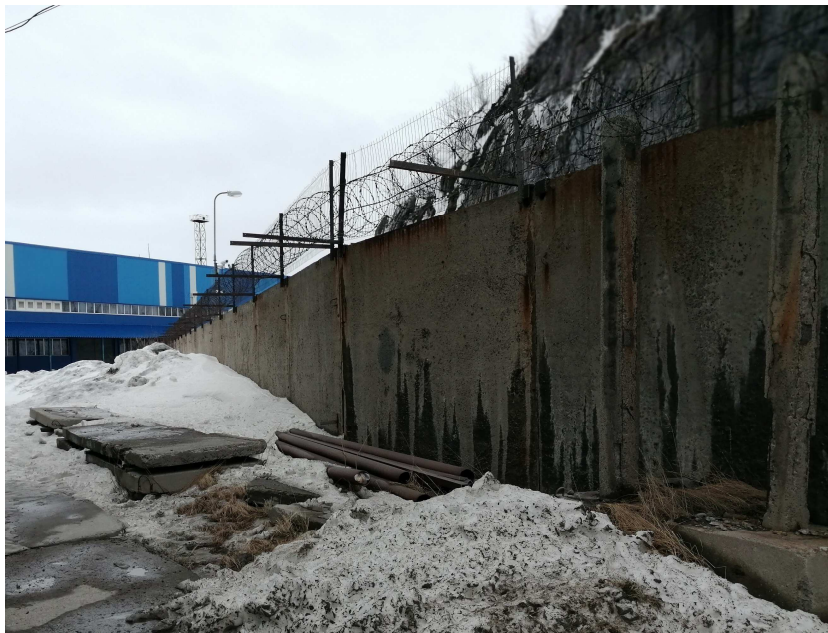
Рисунок 9 – Бетонный забор в восточной части участка работ
