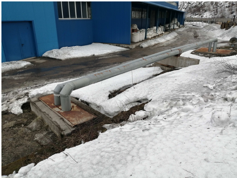
Рисунок 11 – Коммуникации в надземном исполнении
