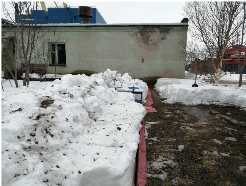
Рисунок 7 – Здание насосной с песколовкой
