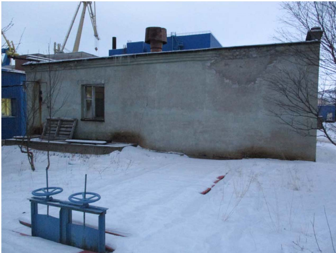
Фото 3 - Общий вид здания насосной в осях 1-3/А.
