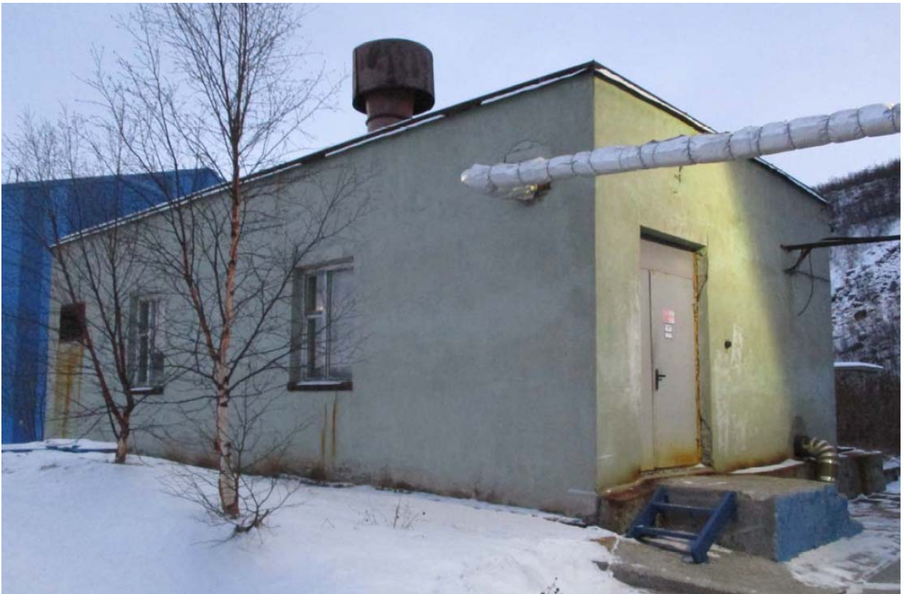
Фото 2 - Общий вид здания насосной в осях 3-1/Б-А.
