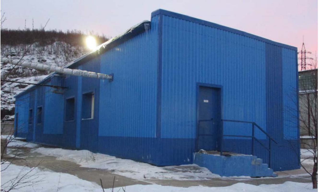
Фото 5 - Общий вид служебно-бытового здания с хлораторной.
