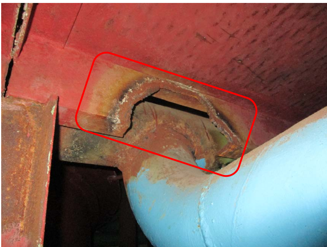
Фото 16. Вырез тела балки проходной площадки служебно-технического здания.
