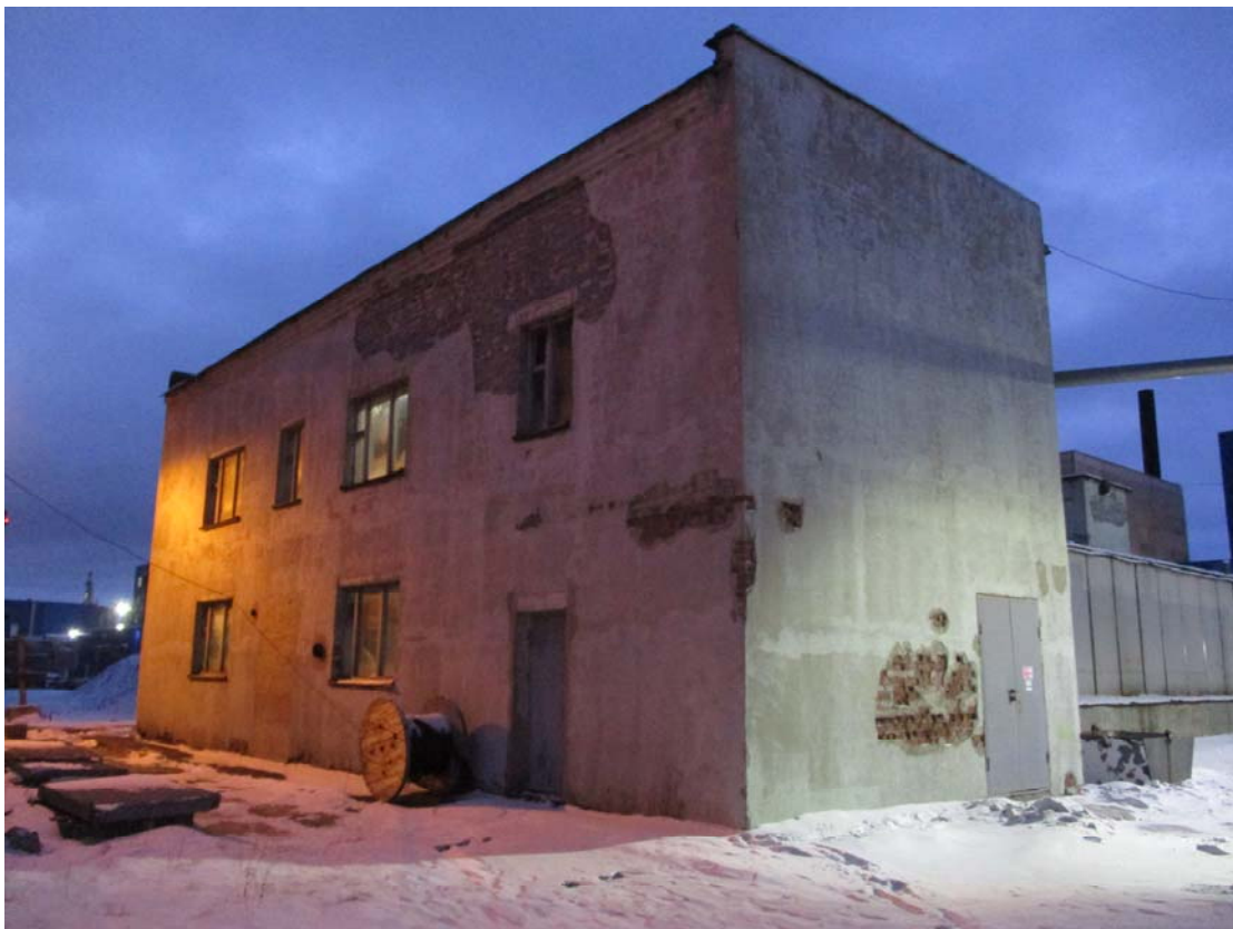
Фото 1. Общий вид служебно-технического здания.
