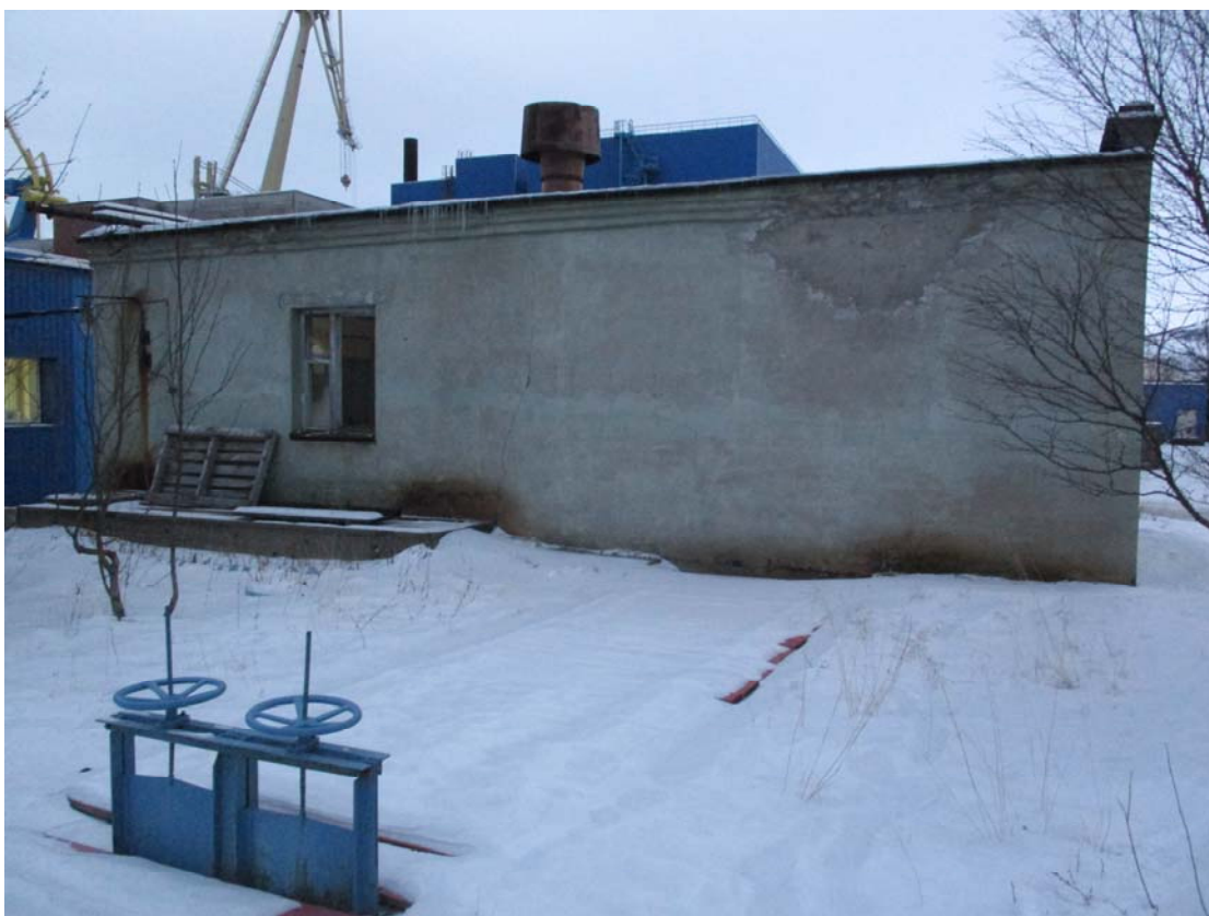
Фото 2. Общий вид здания насосной в осях 1-3/А.
