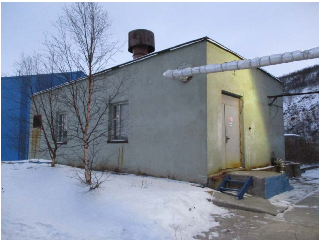
Фото 1. Общий вид здания насосной в осях 3-1/Б-А.
