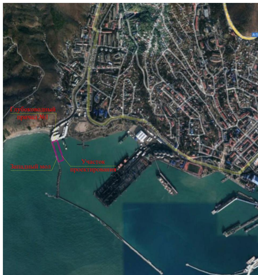
Рис. 4.4. Район проектирования работ
