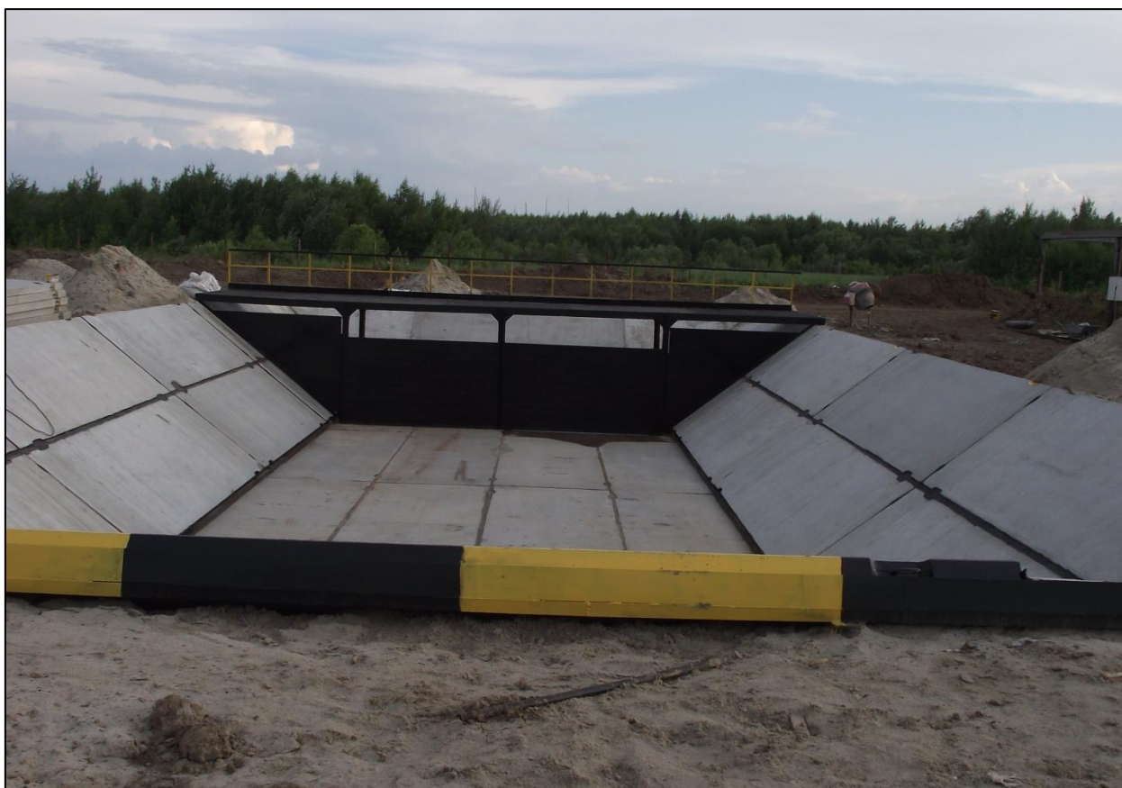
Рисунок № 6. Пример накопительной карты полигона-шламонакопителя для размещения жидких нефтесодержащих отходов
