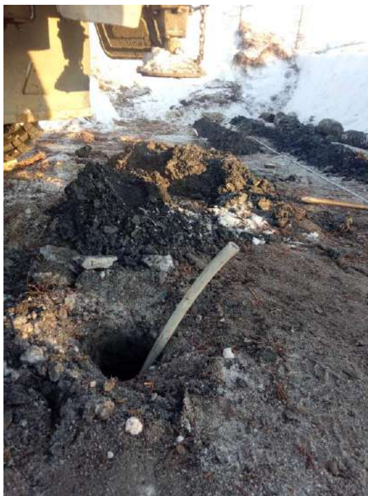
Рисунок 4 – Установка термометрической трубки в скважину
