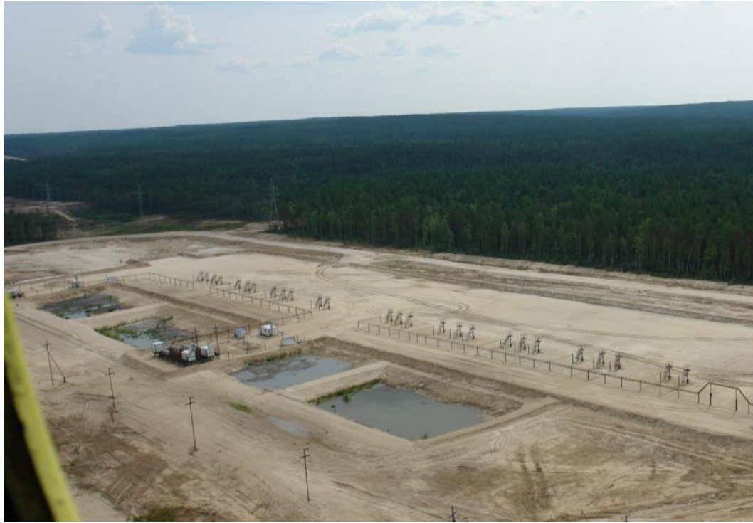
Рисунок 3 - Шламовый амбар после выполнения технических мероприятий по рекультивации
