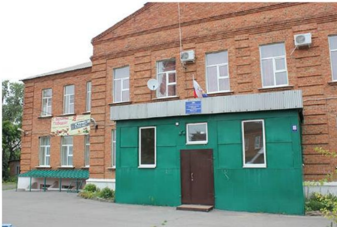
Рис. 3. Здание МБОУ «Большесальская школа № 8»
