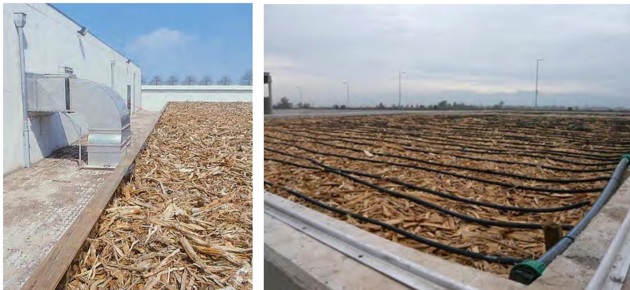
Рис. 2.4 – Вид биофилтра с открытой поверхностью и системой увлажнения
