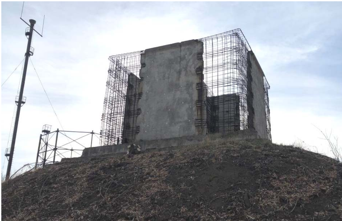
Фото 36 - Общий вид емкостного сооружения по оси «А» в осях «1-3».
