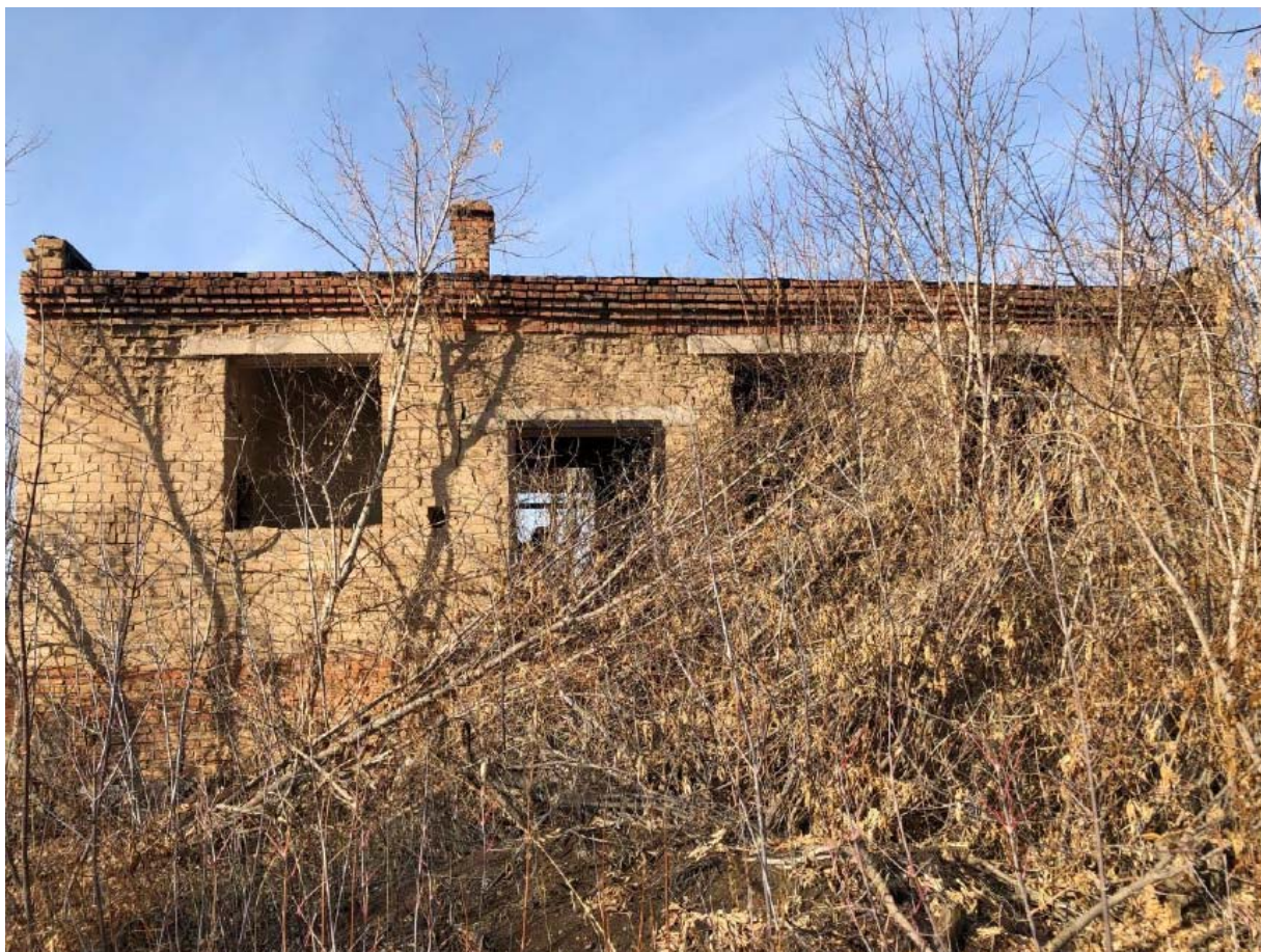
Фото 7 - Общий вид здания насосной станции при метантенках.
