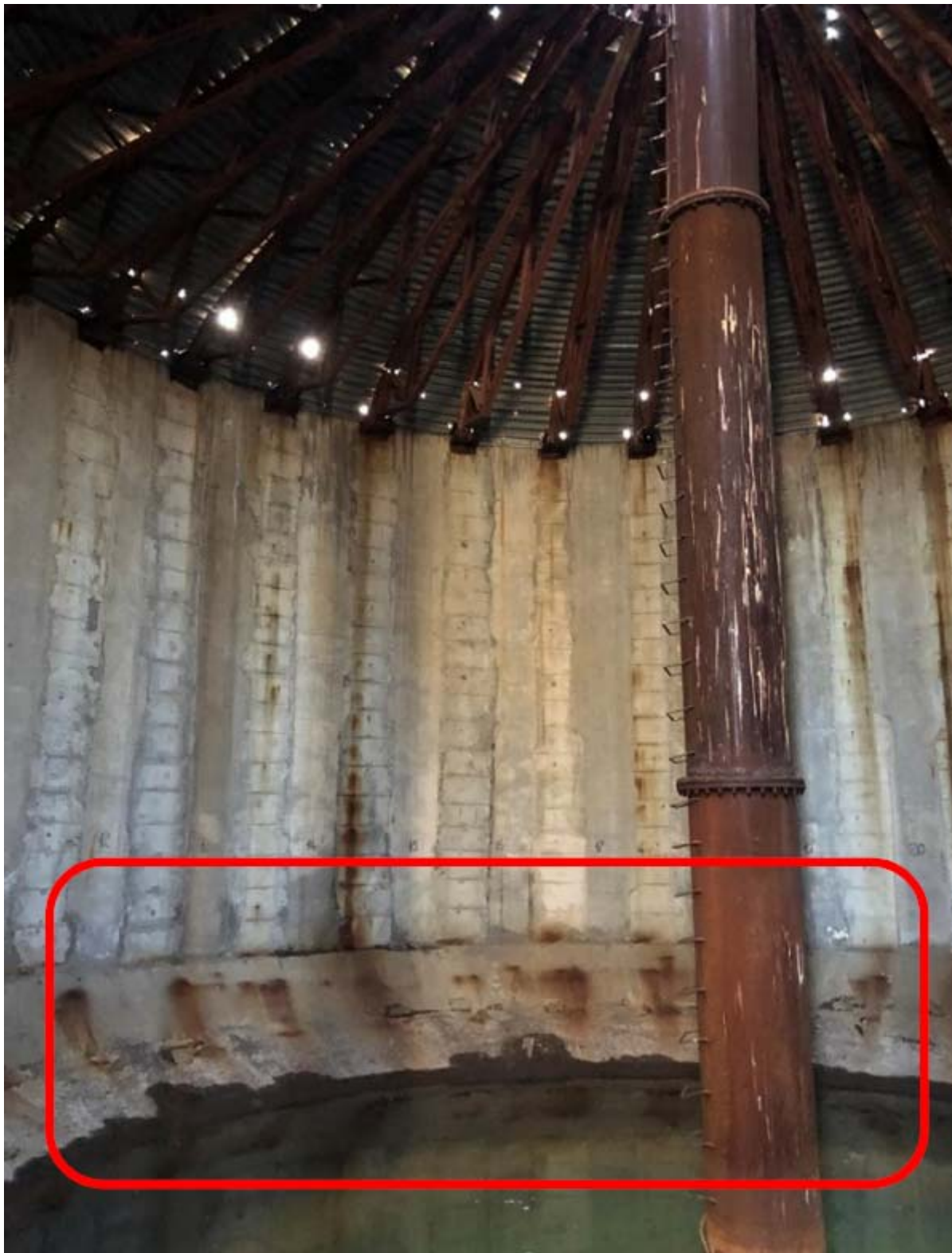
Фото 5 - Общий вид внутреннего пространства метантенка №3.
