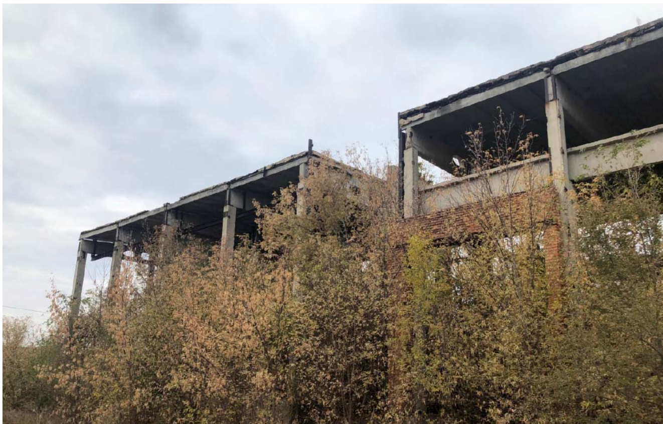
Фото 15 – Фрагмент фасада здания по оси «А».
