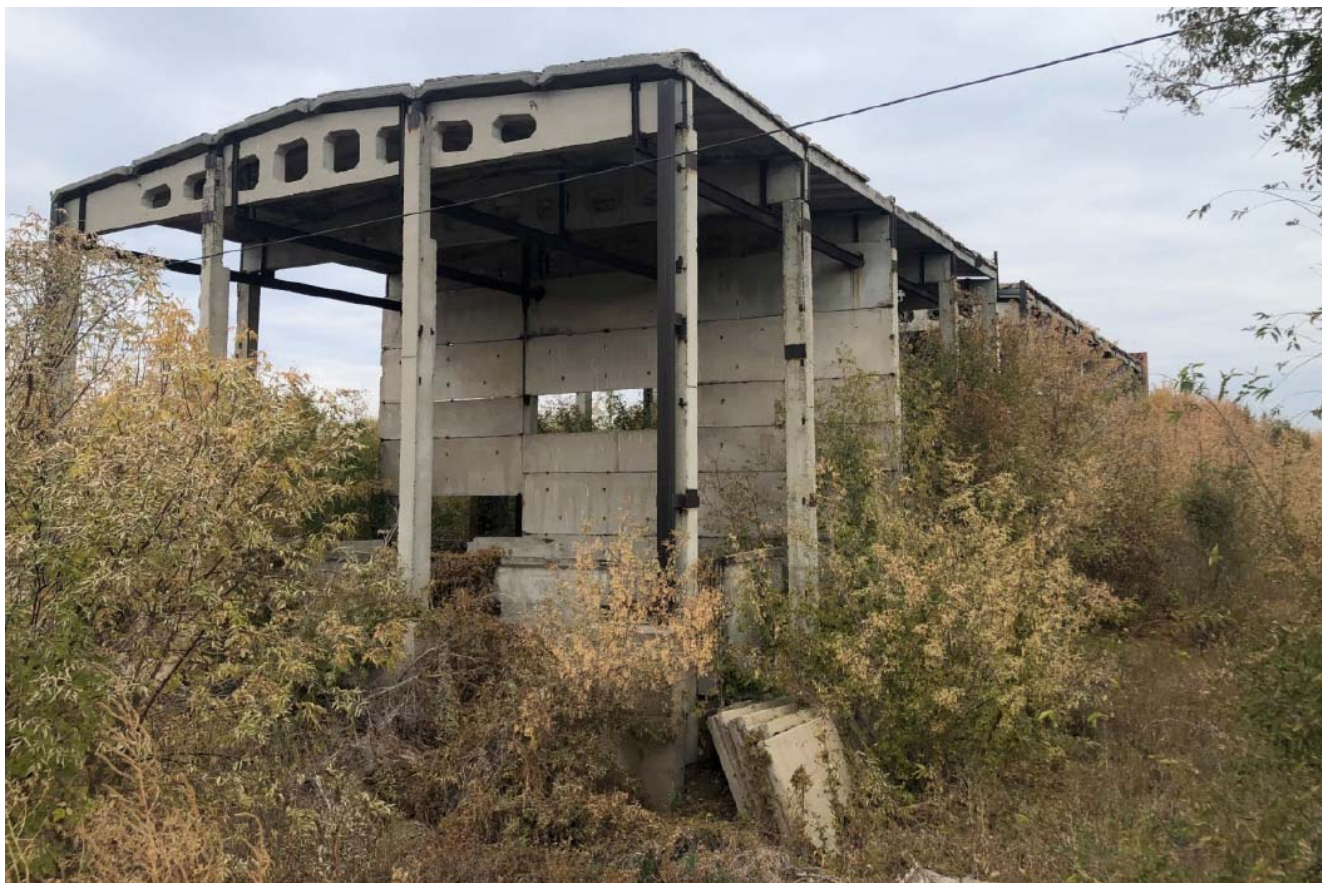
Фото 14 - Общий вид здания литер В38.
