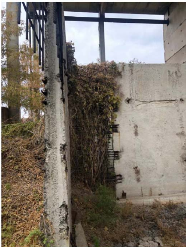
Фото 16 – Общий вид емкостного сооружения в осях «1-3».
