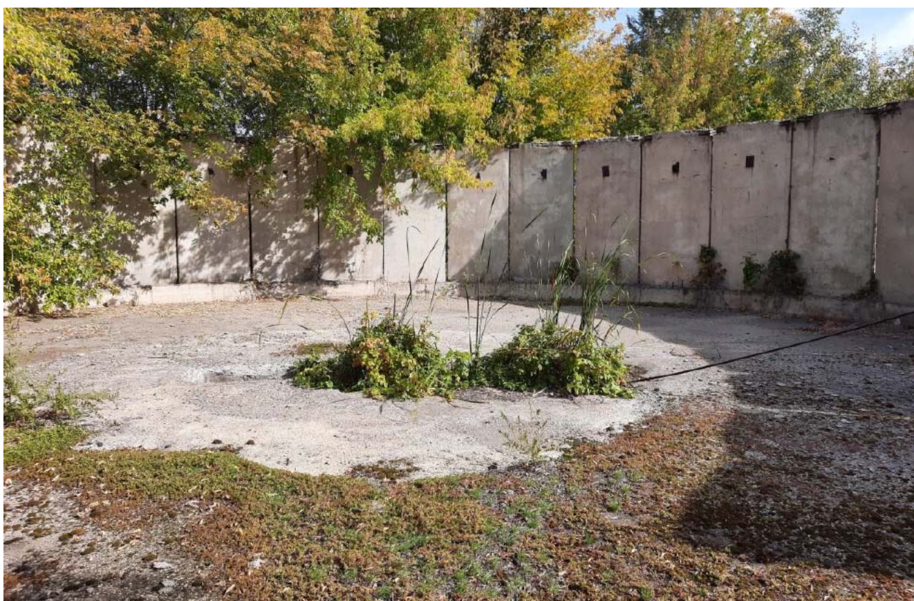
Фото 34 - Общий вид изнутри илоуплотнителя №4.
