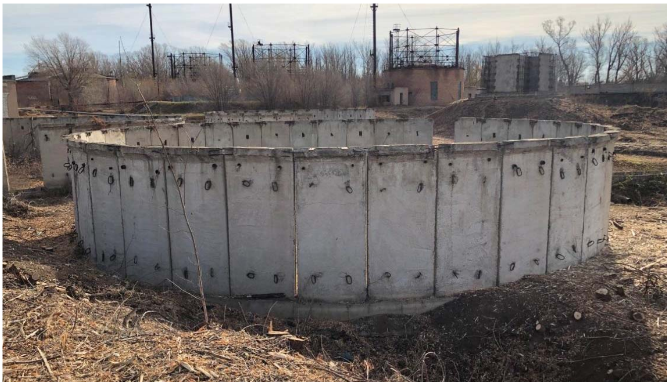
Фото 33 - Общий вид илоуплотнителя №4 в осях «б-2».
