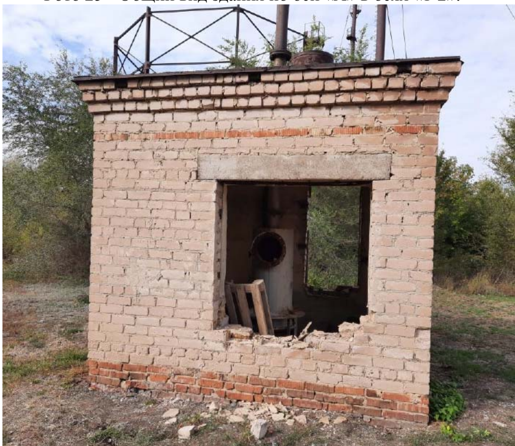
Фото 26 - Общий вид здания по оси «Б» в осях «2-1».
