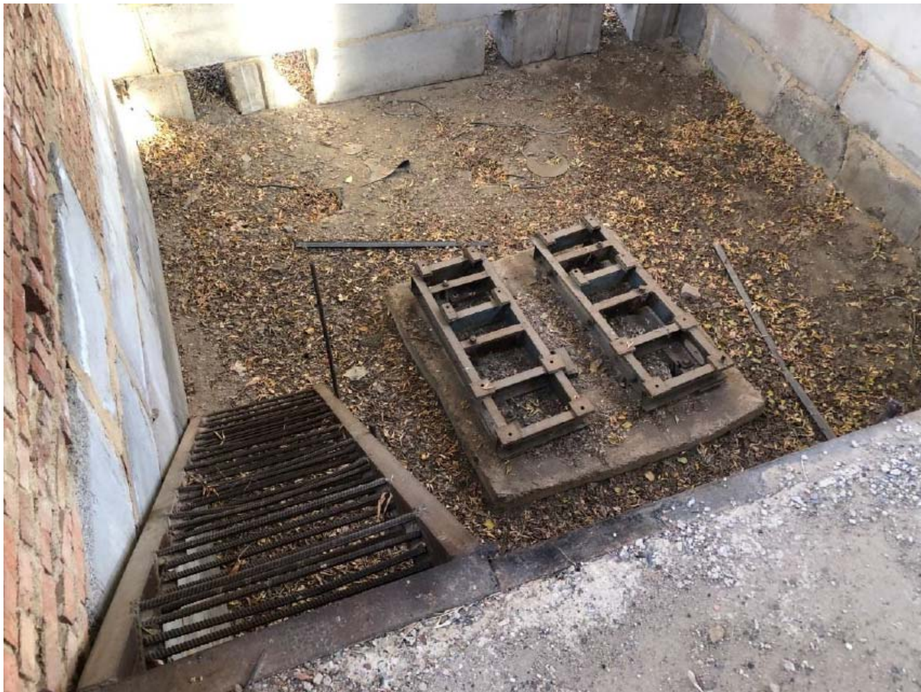
Фото 9 - Общий вид пола здания насосной станции при метантенках.
