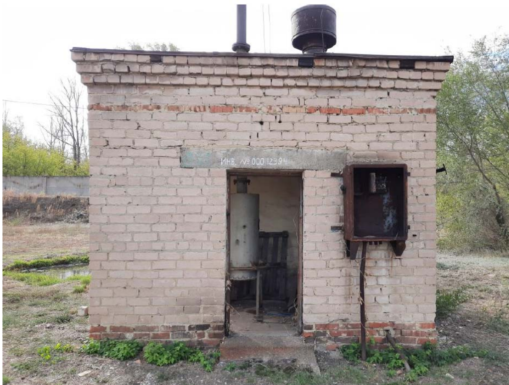
Фото 25 - Общий вид здания по оси «А» в осях «1-2».
