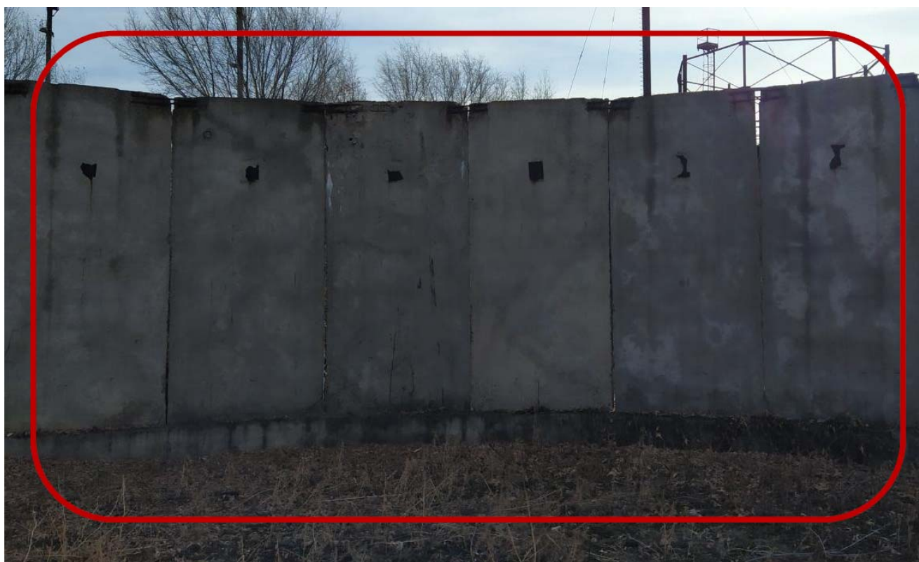
Фото 31 - Общий вид изнутри илоуплотнителя №2 в осях «2-6».
