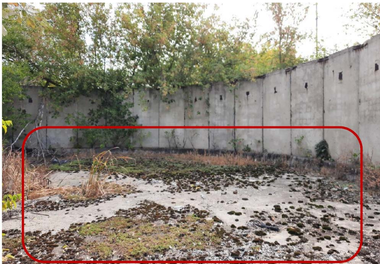
Фото 29 - Общий вид изнутри илоуплотнителя №1 в осях «2-6».
