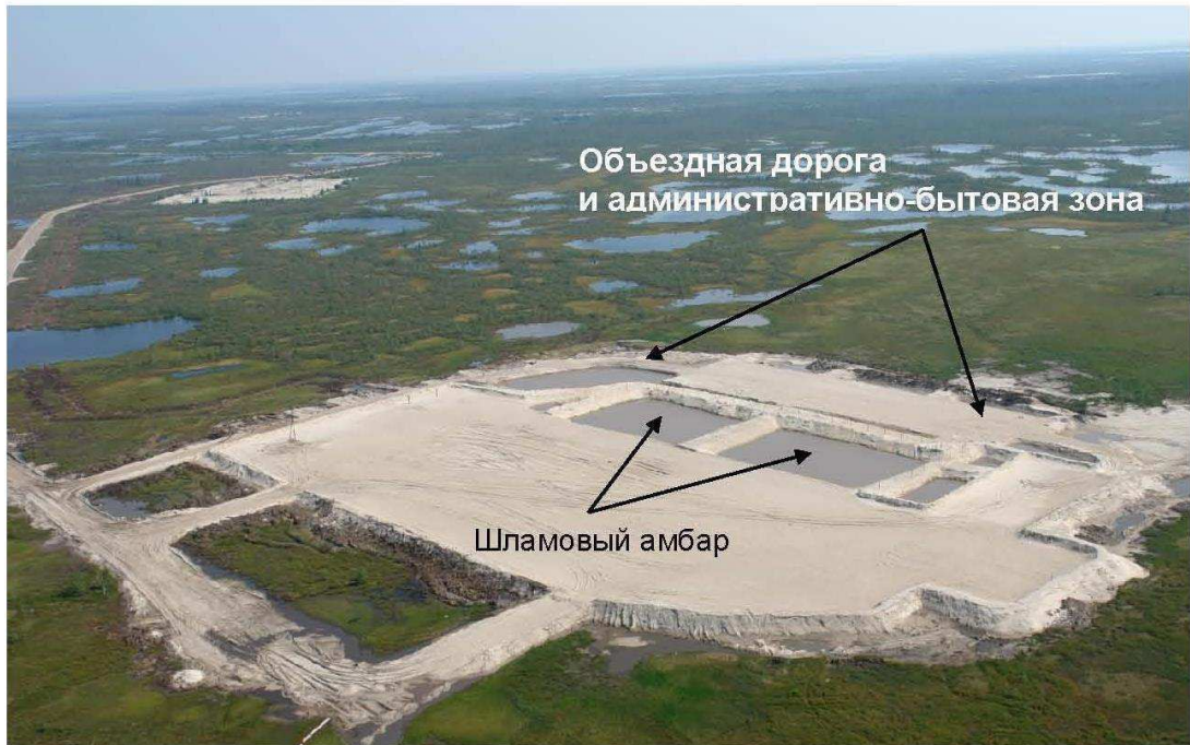
Рисунок 2 – Современная конструкция существующего куста скважин со ША
