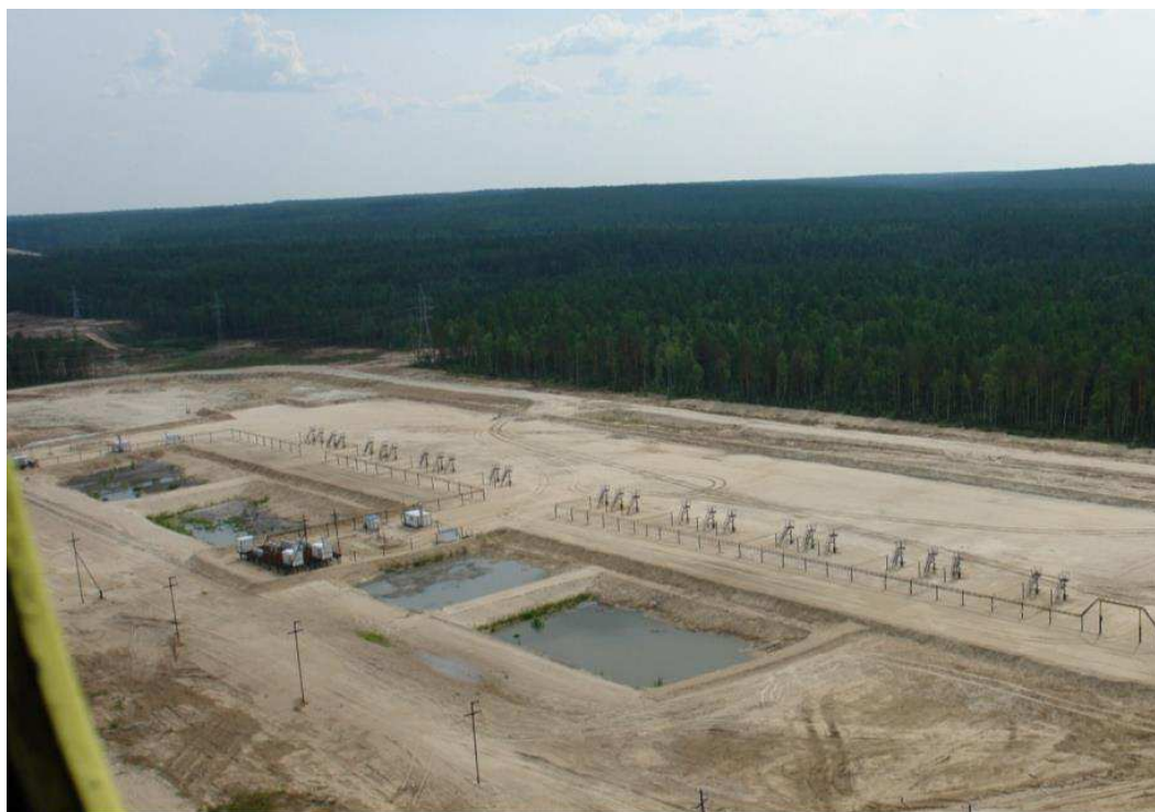
Рисунок 3 - ША после выполнения технических мероприятий по рекультивации
