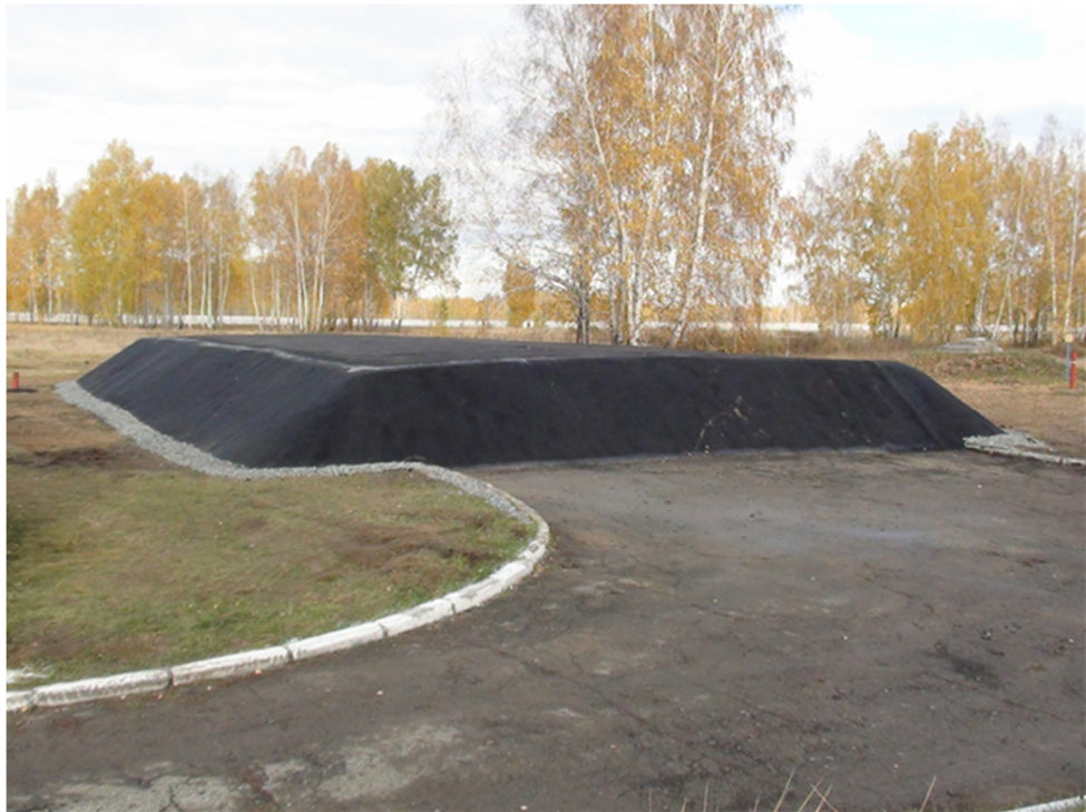
Рис. 2.4.1.2 - Законсервированная емкость № 2 (сооружение № 15)
