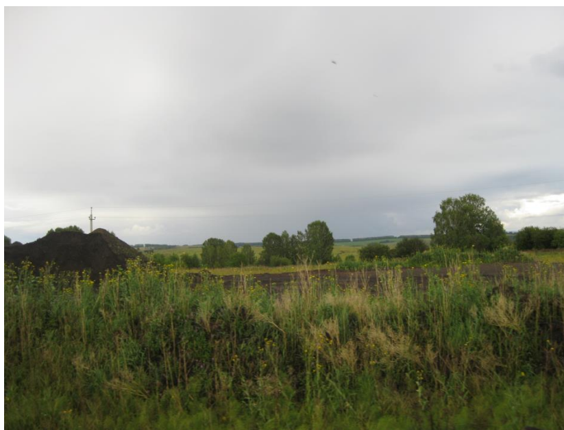
Рисунок 9 - Нарушенный участок испрашиваемой территории
