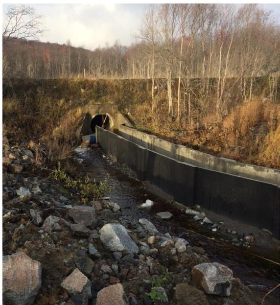
Рисунки Ж.3 – Водоотводной лоток ручья без названия после водопропуска через автодорогу Мишуково – Снежногорск
