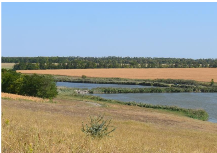
Рисунок 3.3 – Вид дамбы на р. Терновка, район ст. Новоромановская
