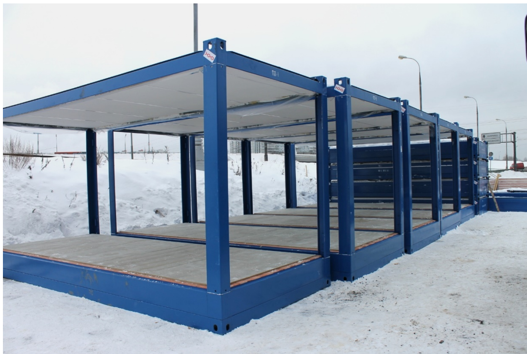
Рис. 10. Сборка каркасов блок-контейнеров
