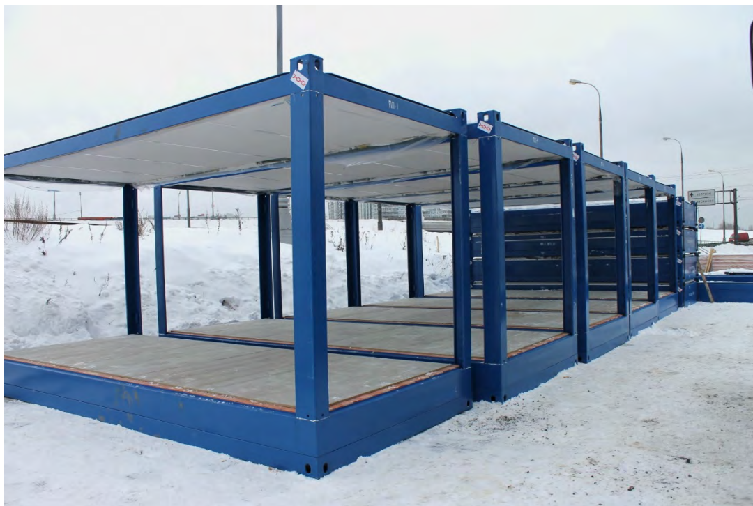
Рис. 10. Сборка каркасов блок-контейнеров
