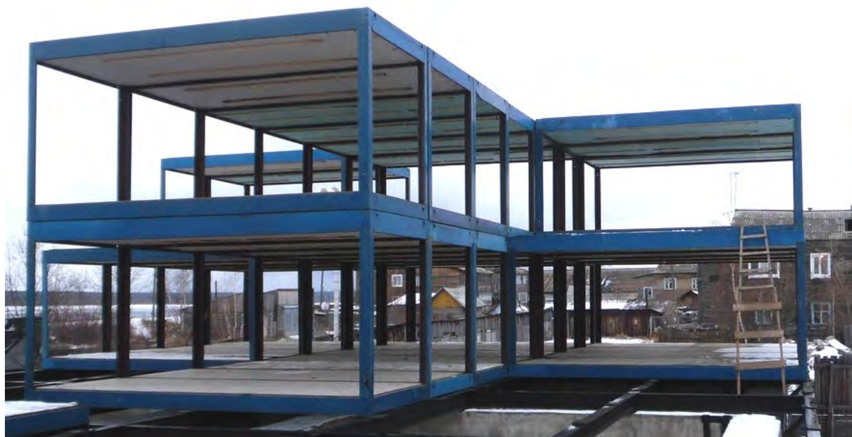
Рис. 11. Монтаж каркасов блок-контейнеров в проектное положение
