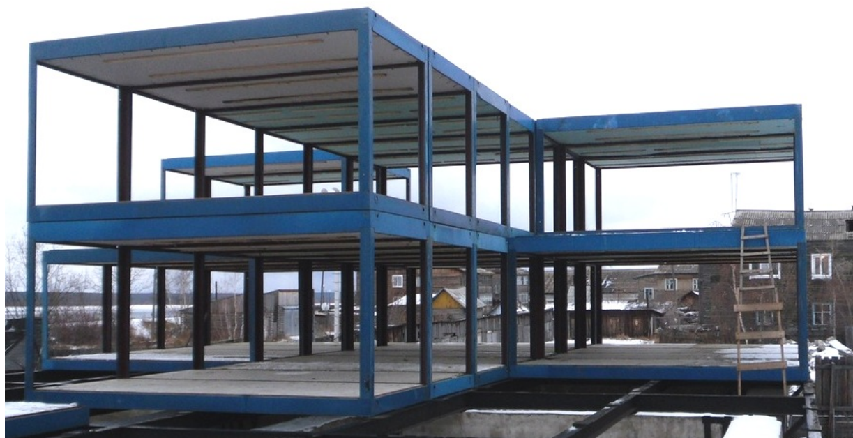
Рис. 11. Монтаж каркасов блок-контейнеров в проектное положение
