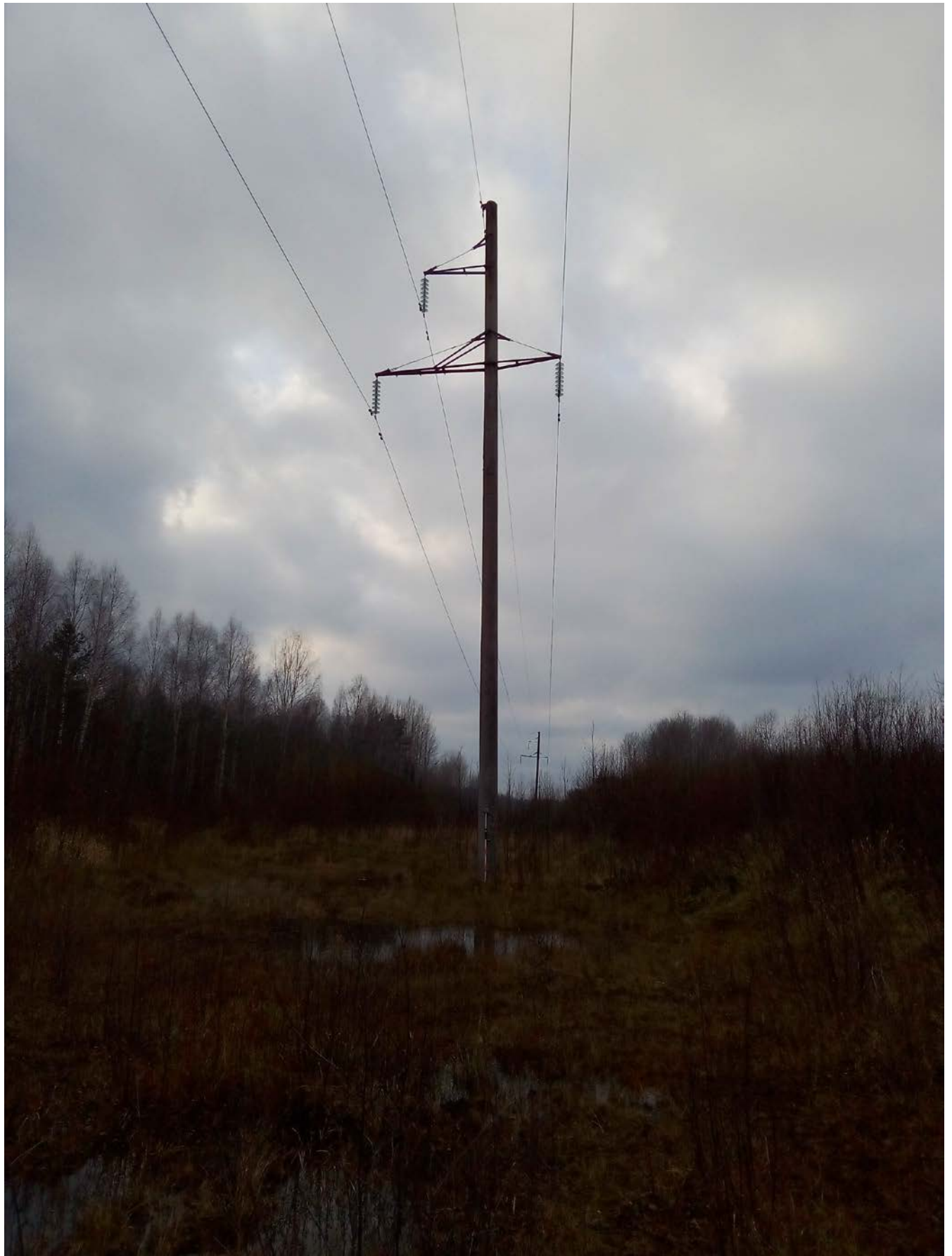
Рис. 7.2 Общий вид участка изысканий
