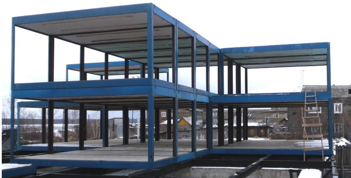
*Рис. 11. Монтаж каркасов блок-контейнеров в проектное положение*
