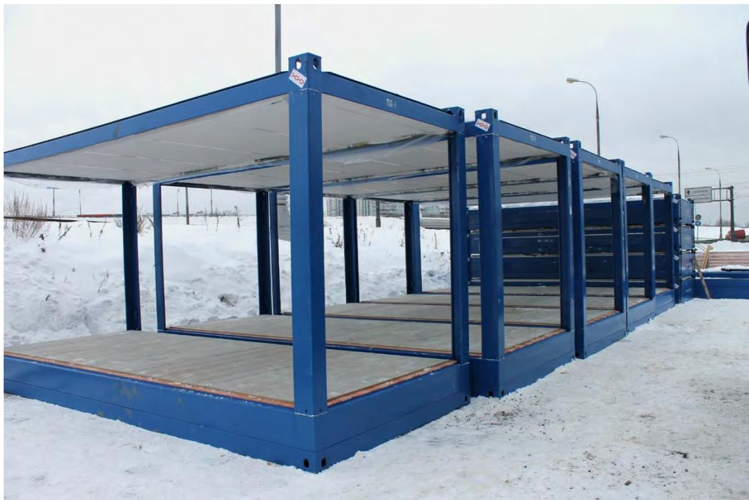
*Рис. 10. Сборка каркасов блок-контейнеров*
