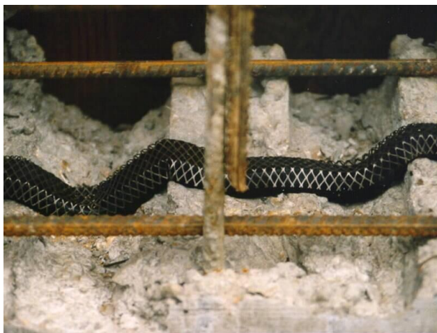
Рисунок 33 - Способы крепления бентонитового шнура: А) Дюбель-гвоздями Б) При помощи клея на полимерной основе В) При помощи стальной сетки и дюбелей
