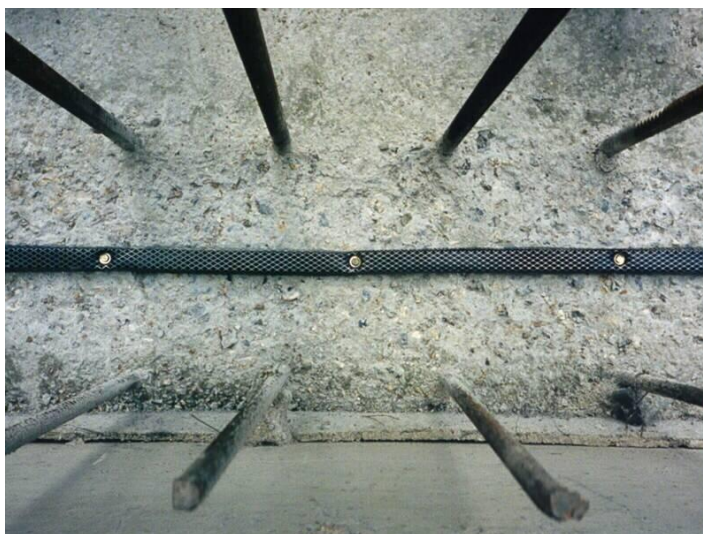
Рисунок 29– Устройство рабочих швов бетонирования при устройстве изоляции из бентонитовых матов: А) Схема Б) Фото
