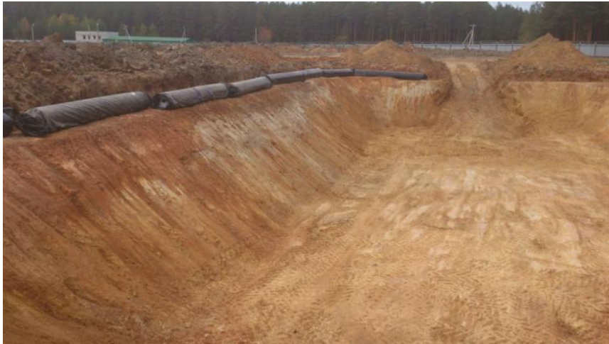
Рисунок 10 – Подготовленное основание выемки
