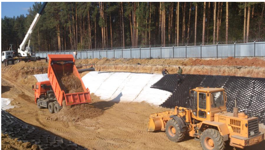
Рисунок 23 – Устройство защитного слоя при укладке бентонитовых матов
