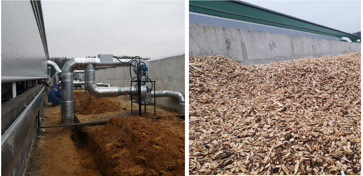
Рисунок 2.3 – Заполнение биофильтра и система вентиляции
