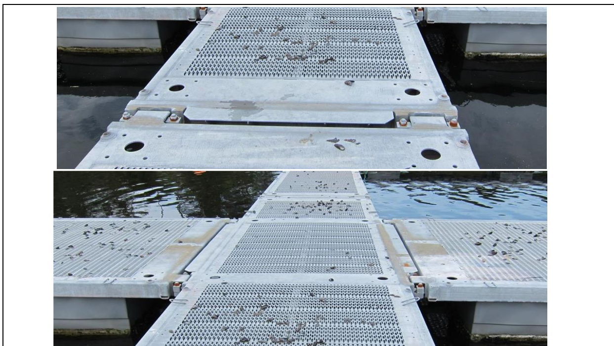
Рисунок 5.2 – Крепления понтонов
