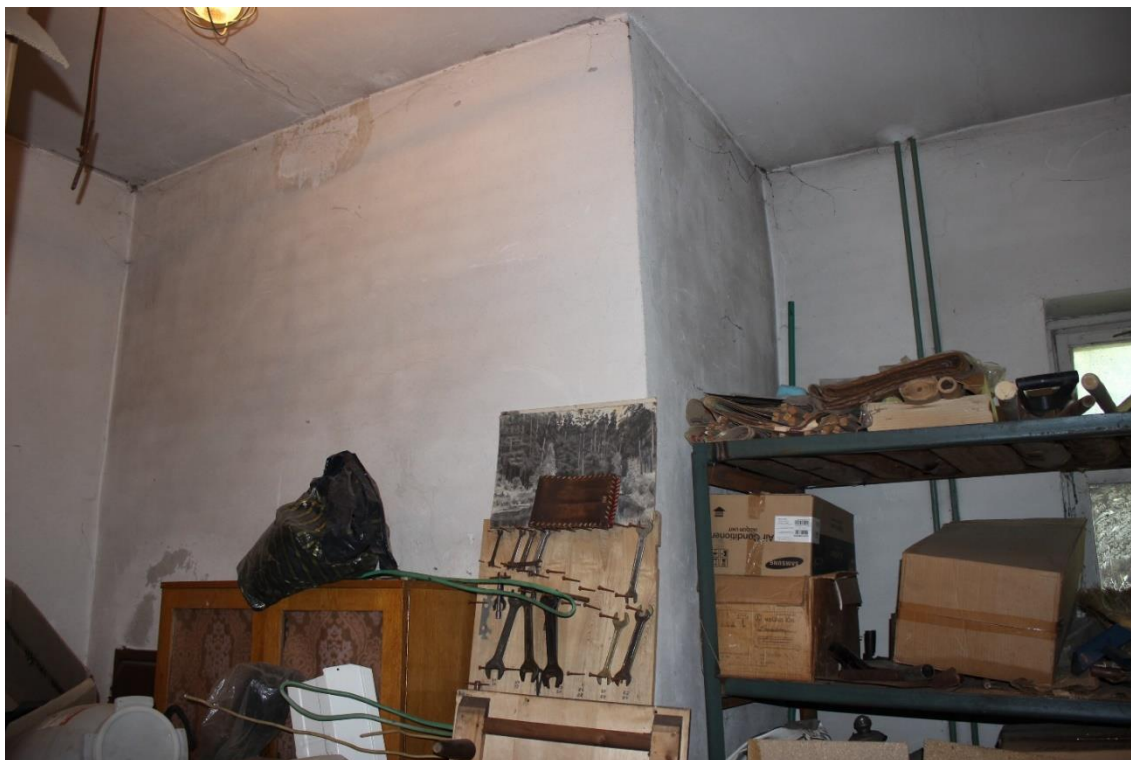
Фото А.1. Общий вид наружных стен изнутри
