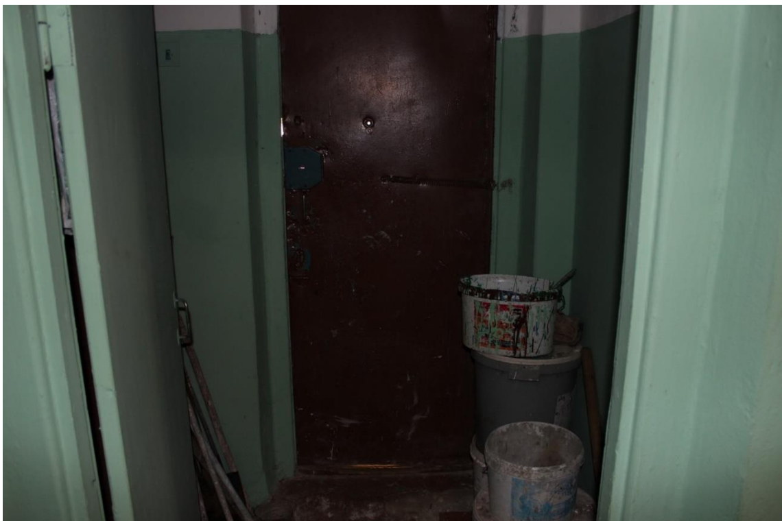
Фото 4. Общий вид входной группы в здании
