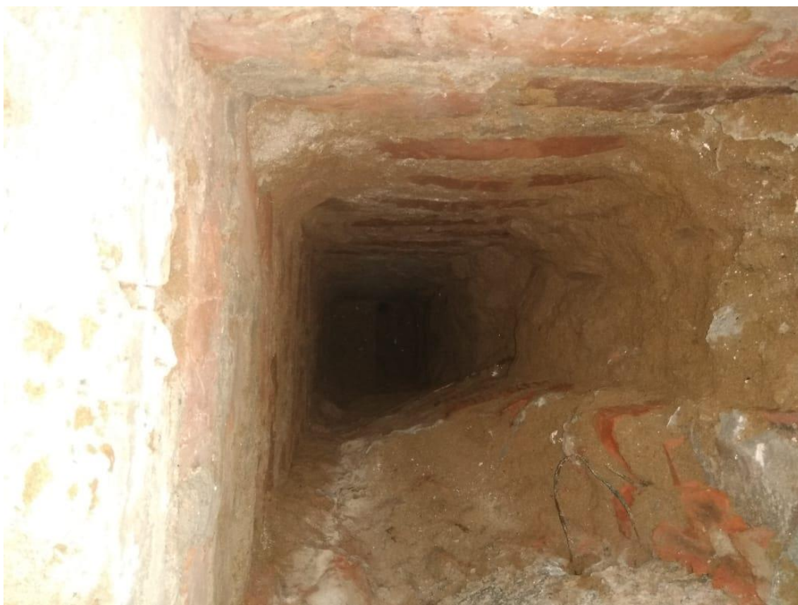
Фото30. Проходка шурфа в осях 3/А
