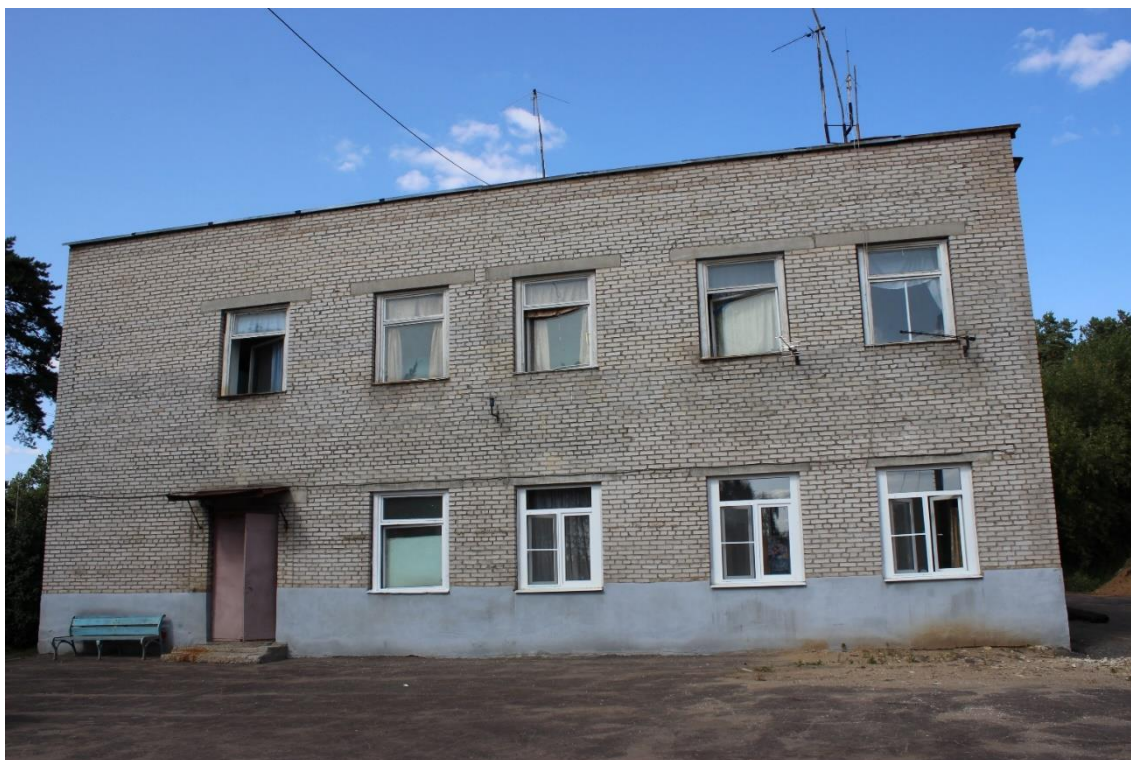
Фото А.23. Общий вид фасада по оси «А, 1-4»
