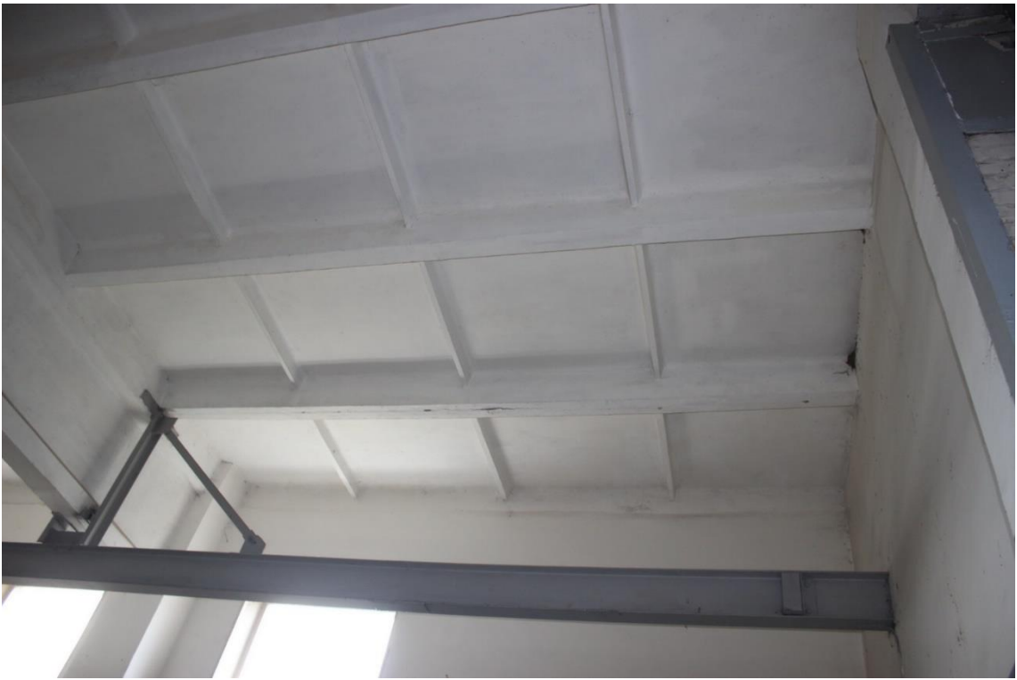
Фото 13. Общий вид плит покрытия производственного зала
