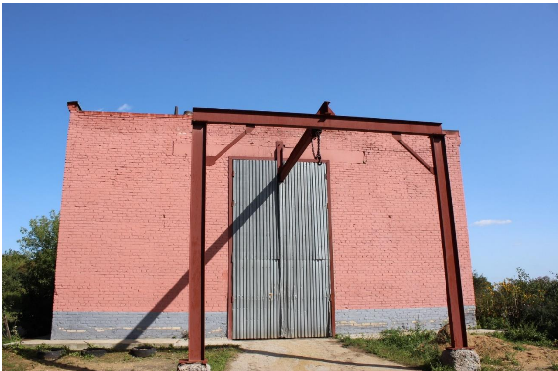
Фото 16. Общий вид фасада по оси «1»
