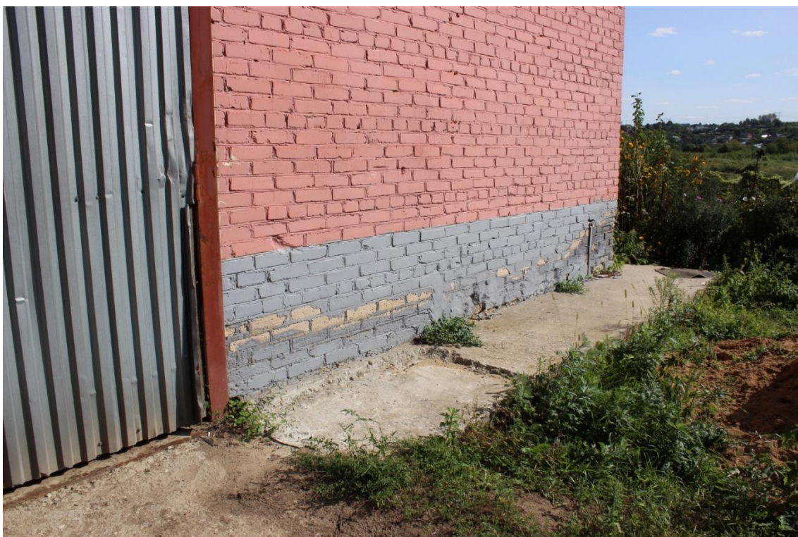
Фото 18. Общий вид бетонной отмостки и цокольной части стены
