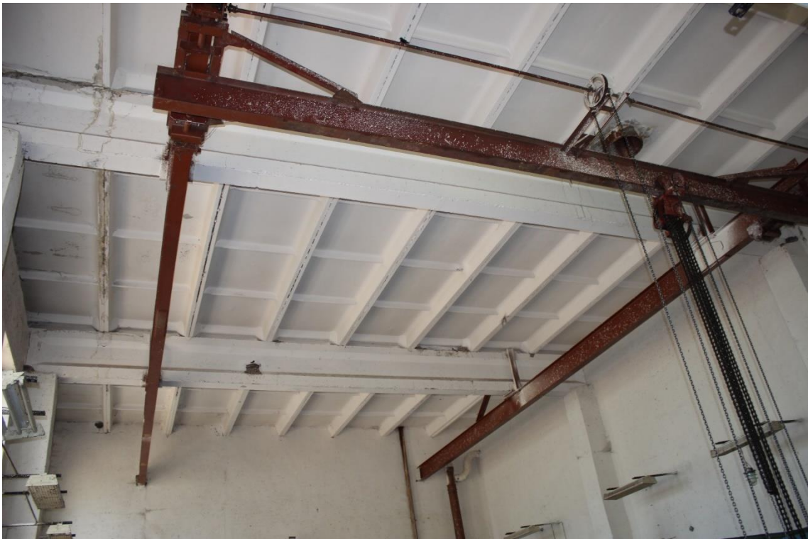
Фото А.11. Общий вид покрытия производственного зала
