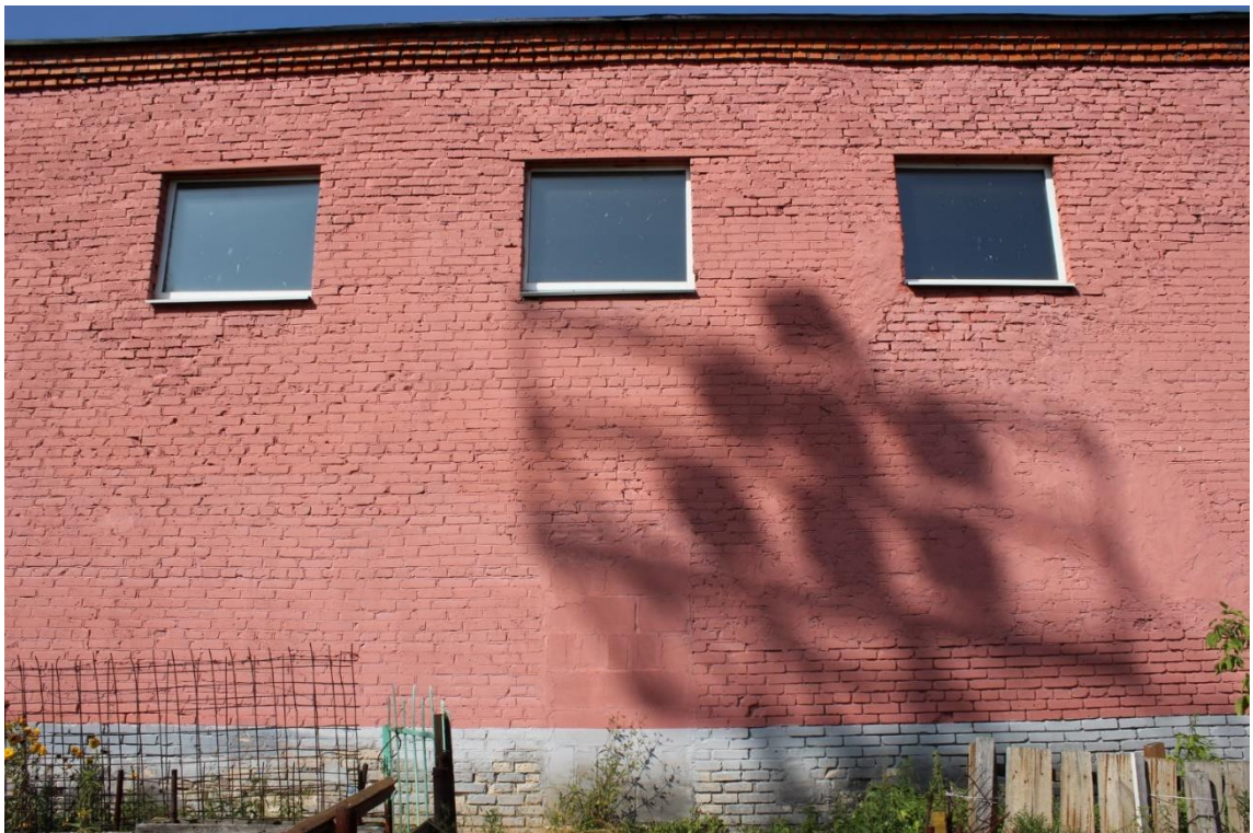
Фото 20. Общий вид наружной стены по оси «А»
