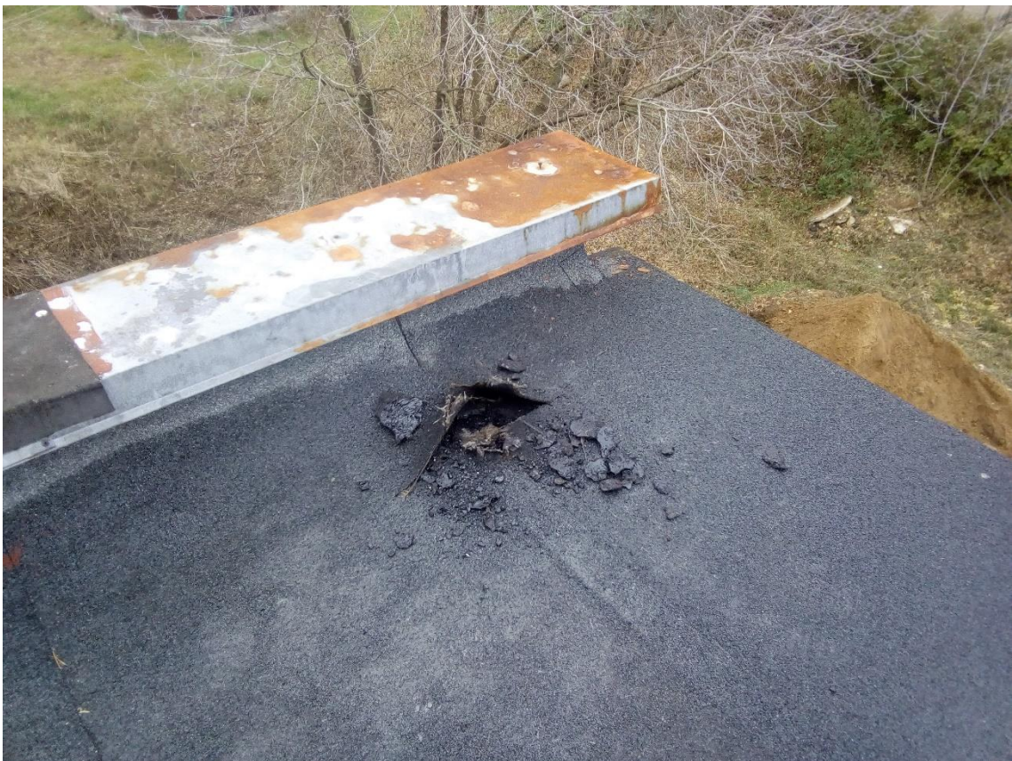
Фото А.38. Вскрытие кровли
