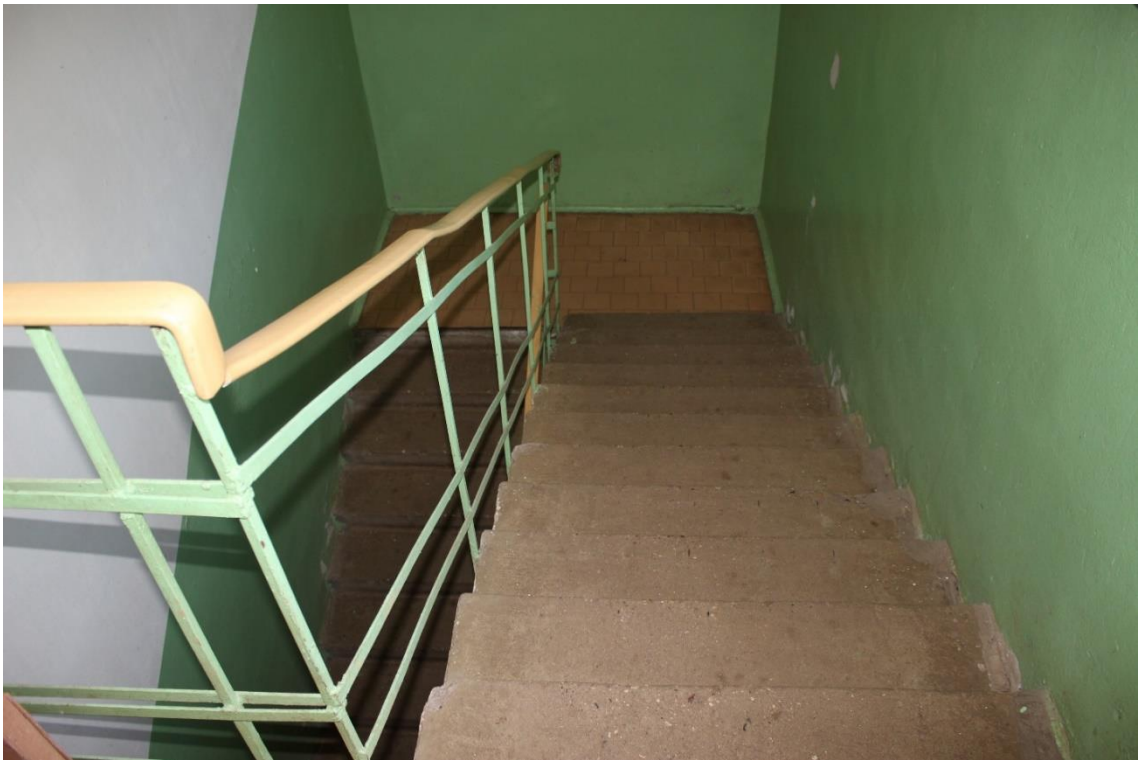
Фото А.9. Общий вид лестницы
