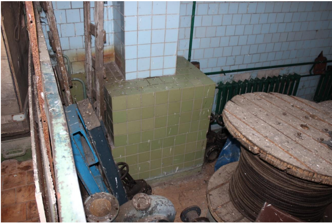
Фото А.13. Общий вид фундамента под кирпичную пилястру
