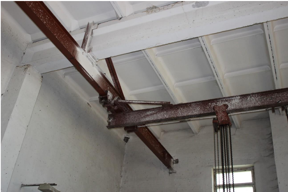
Фото А.17. Крепление подкрановых путей к балке покрытия
