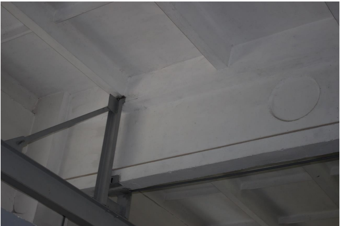
Фото 14. Крепление подкрановых балок к балкам покрытия
