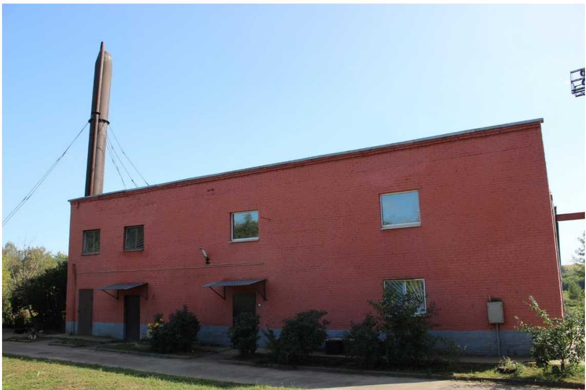
Фото 26. Общий вид фасада по оси «В»
