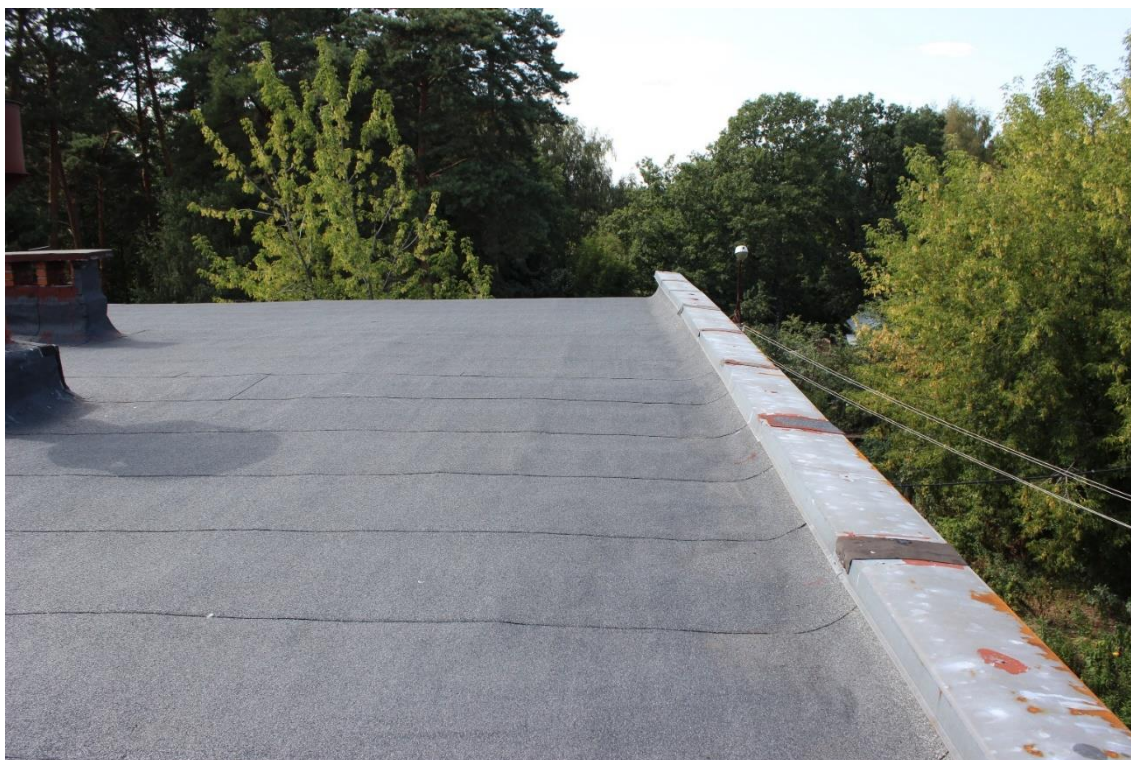
Фото А.21. Примыкание кровли к парапетной части
