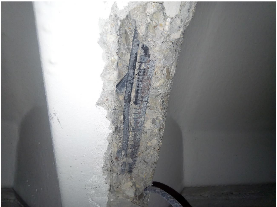
Фото А.36. Вскрытие ребра плиты
