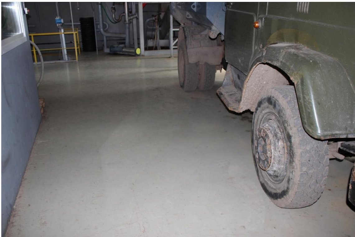
Фото 15. Общий вид железобетонного пола в здании
