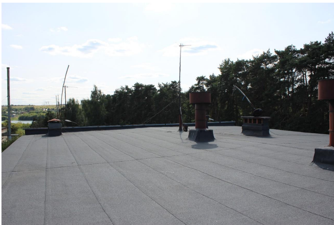
Фото А.20. Общий вид мягкой кровли
