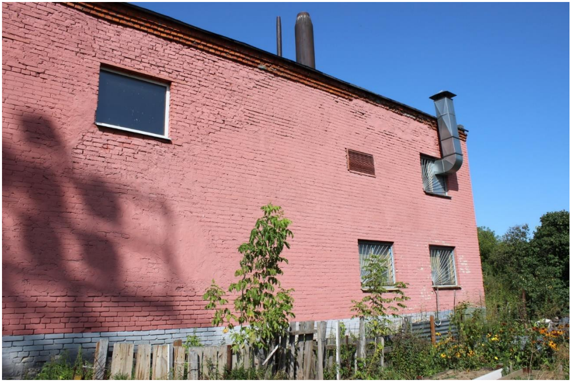
Фото 19. Общий вид фасада по оси «А»
