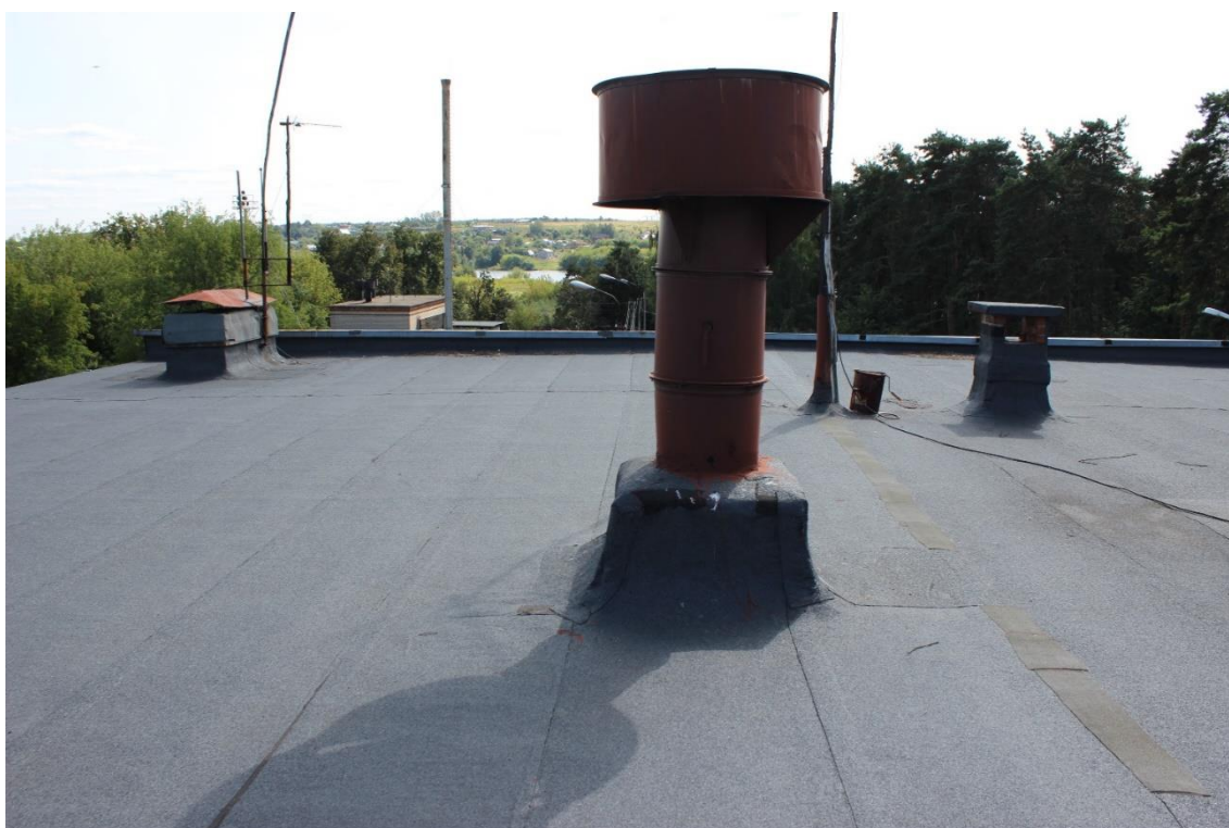
Фото А.22. Вентиляционные выходы на кровлю
