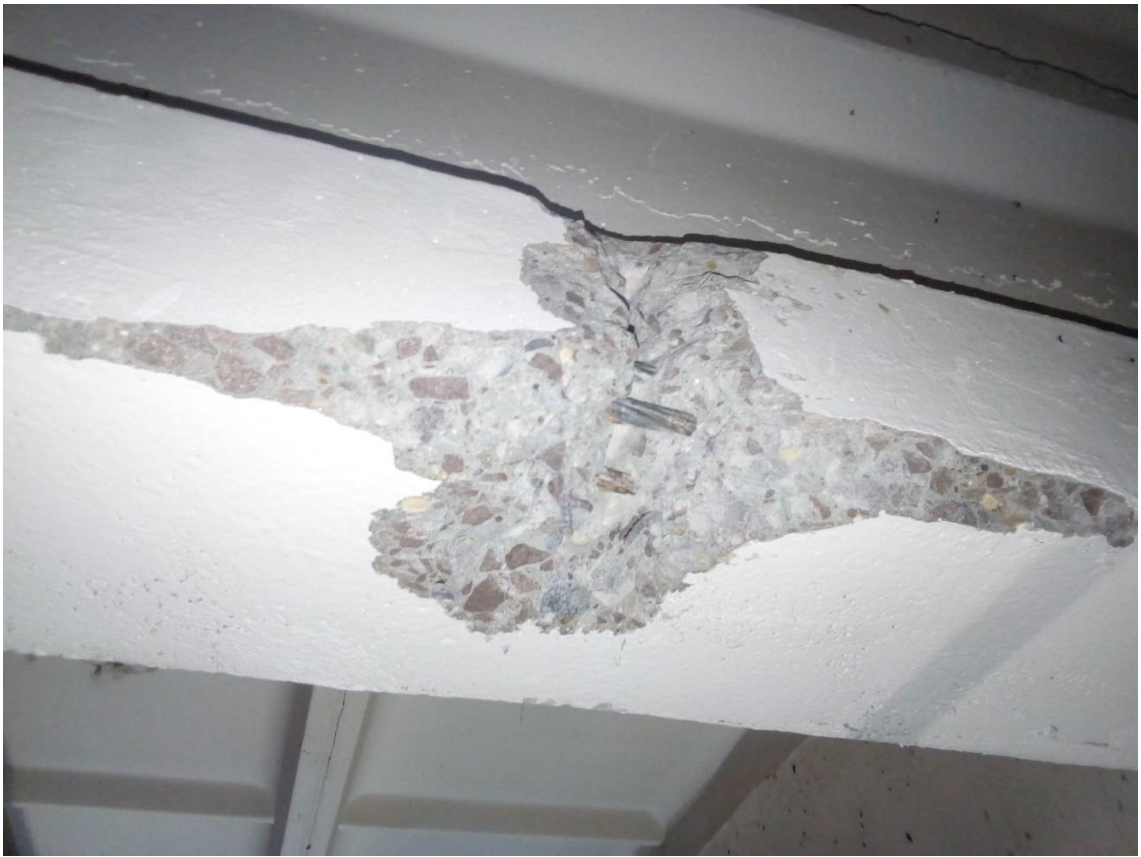
Фото А.35. Вскрытие балки
