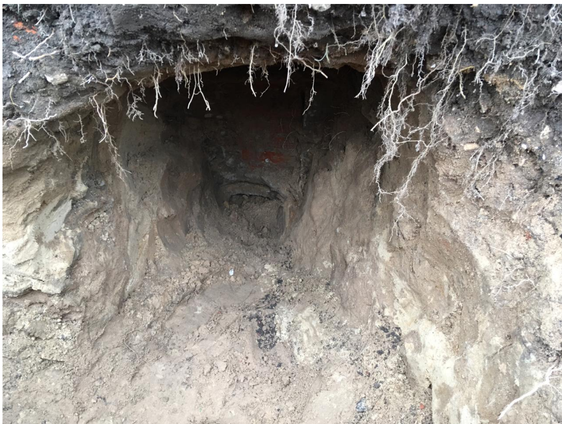
Фото30. Проходка шурфа в осях 3/А
