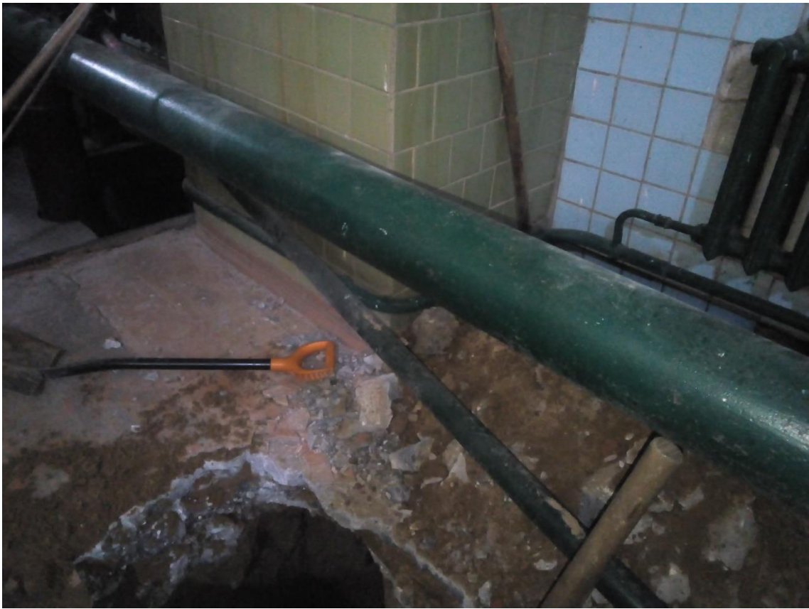
Фото А.37. Проходка шурфа в осях 4/В
