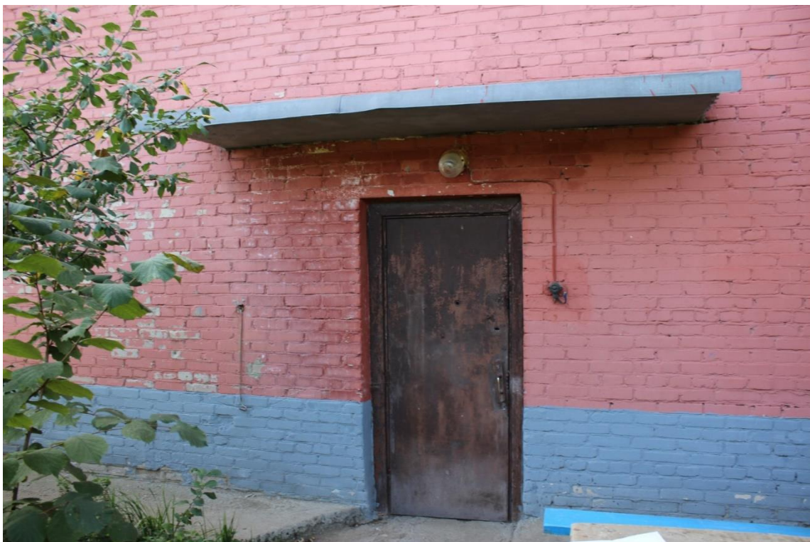
Фото 24. Общий вид наружной стены по оси «5»
