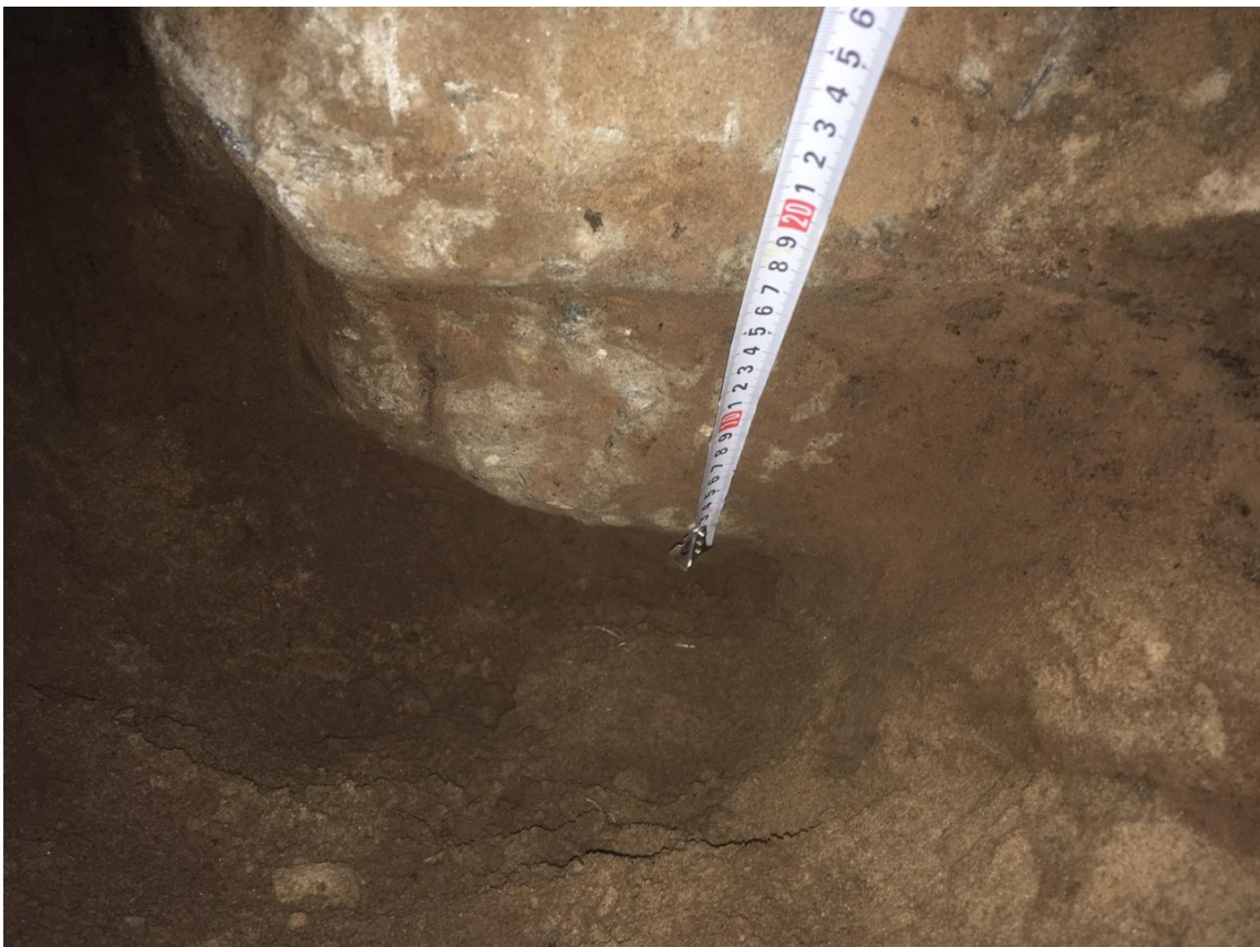
Фото 29. Проходка шурфа в осях 5/А
