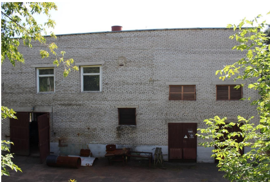
Фото А.30. Общий вид фасада по оси «Д»
