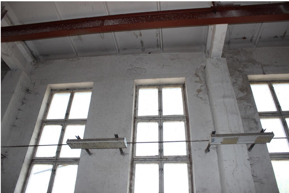
Фото А.14. Общий вид наружной стены по оси «4»
