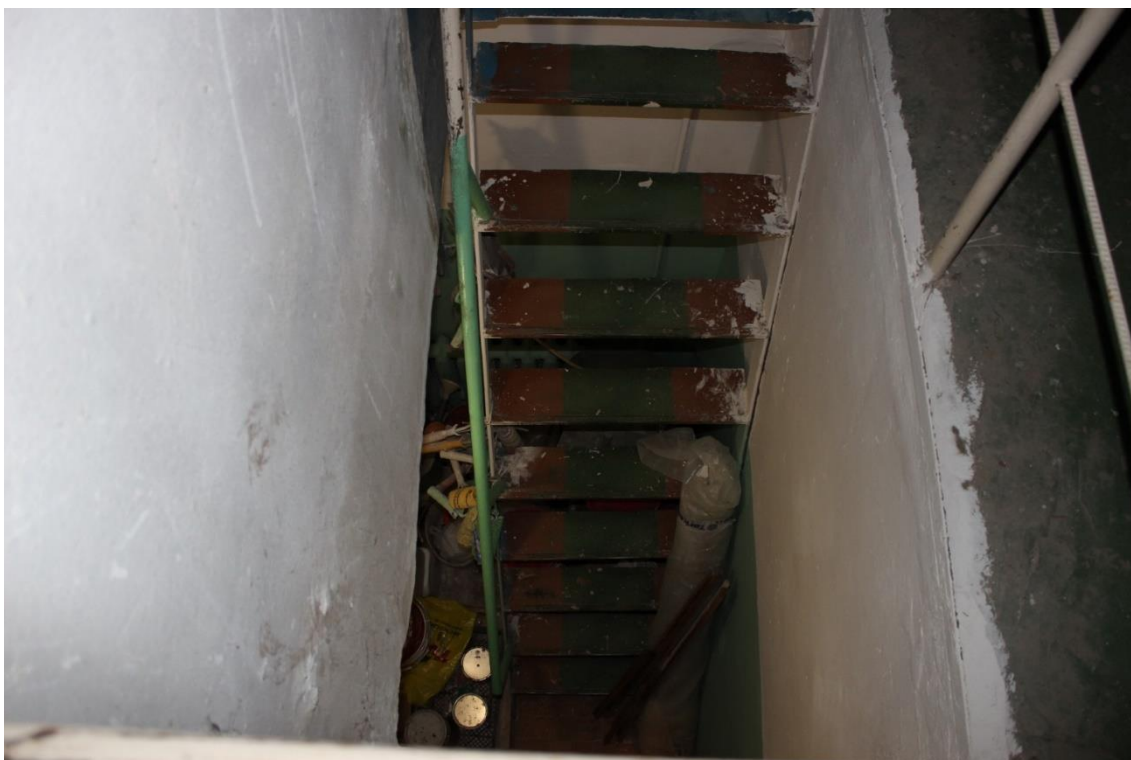
Фото 9. Общий вид металлической лестницы
