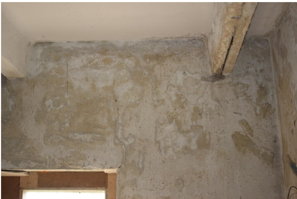
Фото 7. Следы замачивания, трещины, локальные разрушения отделочного слоя
