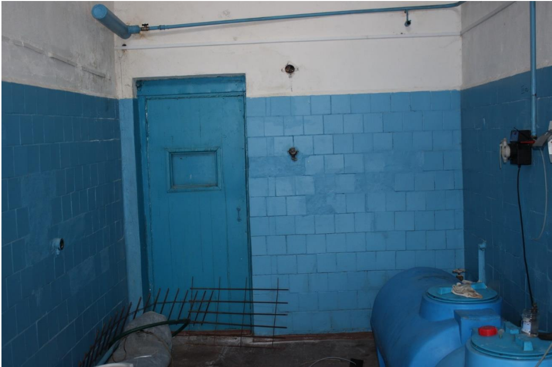
Фото 1. Общий вид стен цеха механического обезвоживания
