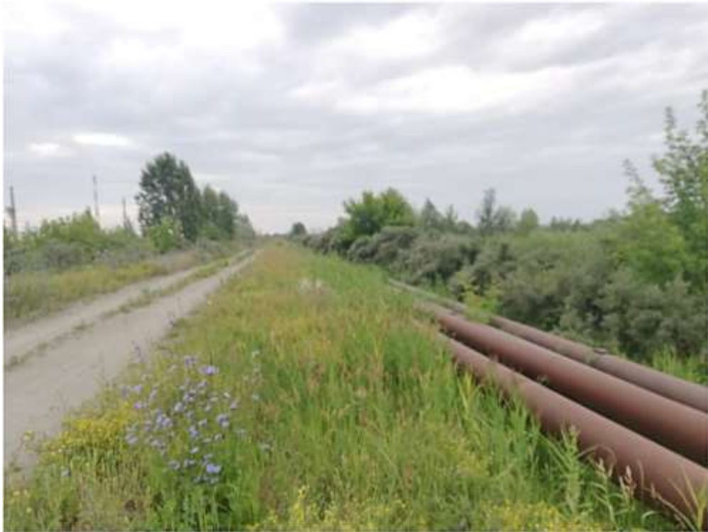
Рисунок 4 - Дорога на гребне ограждающей дамбы
