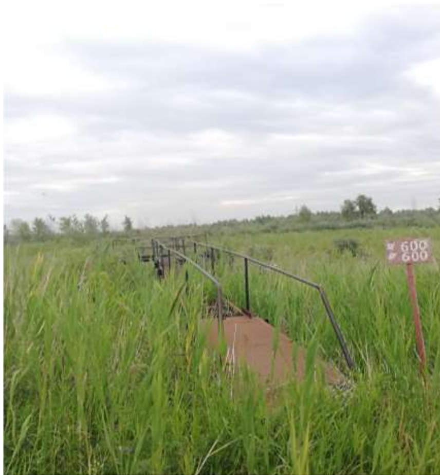
Рисунок 5 - Шандорный колодец секции №2 со служебным мостиком
