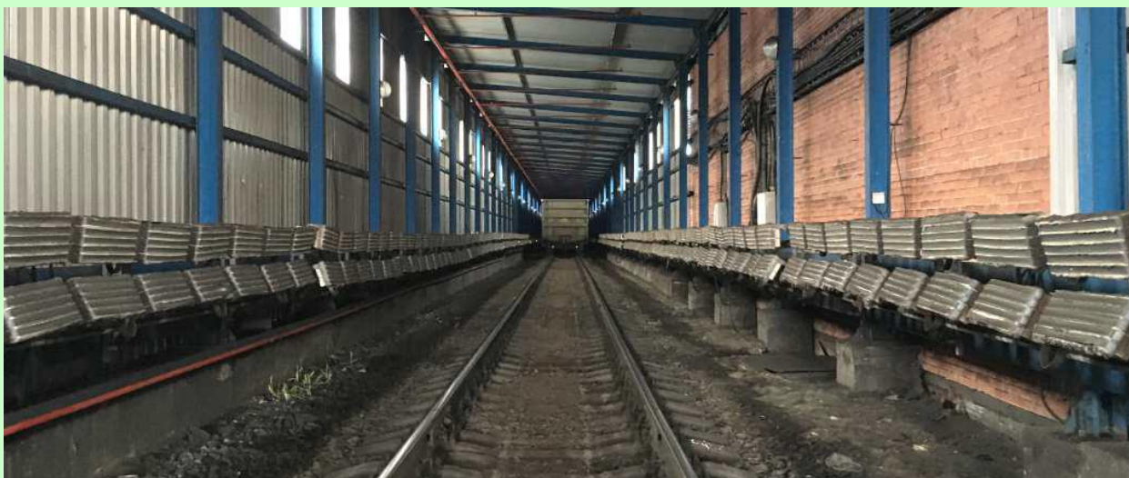
Рисунок 2.3 – Туннели для размораживания вагонов
