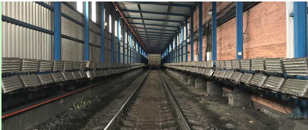
Рисунок 4.3 – Туннели для размораживания вагонов
