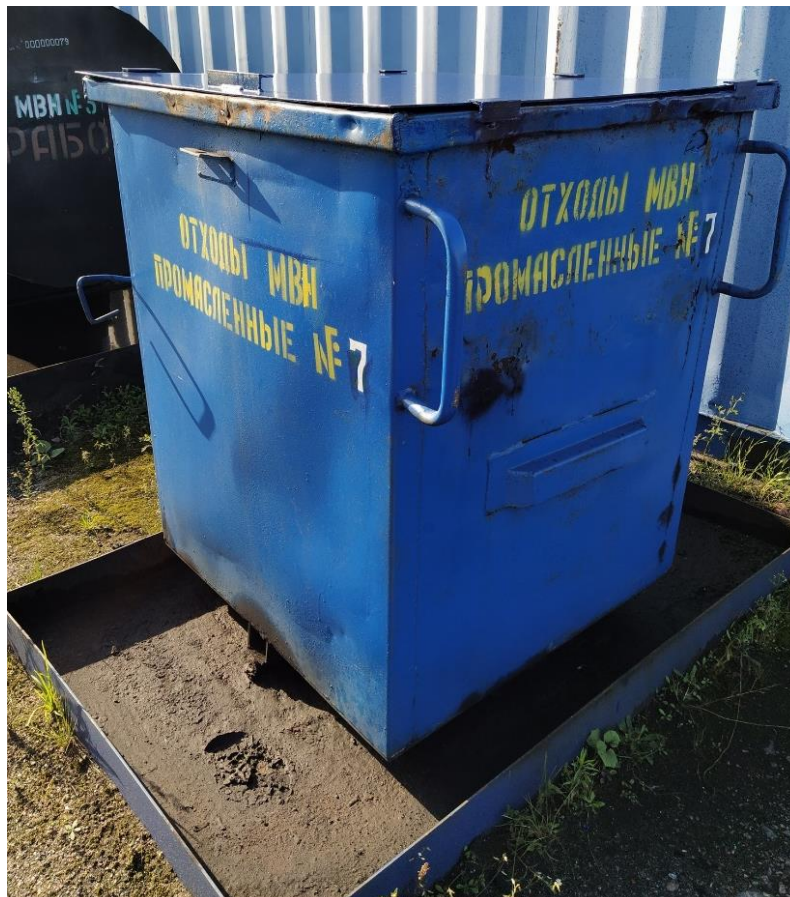
Рисунок 2.23 – Тара для накопления нефтезагрязненных отходов
