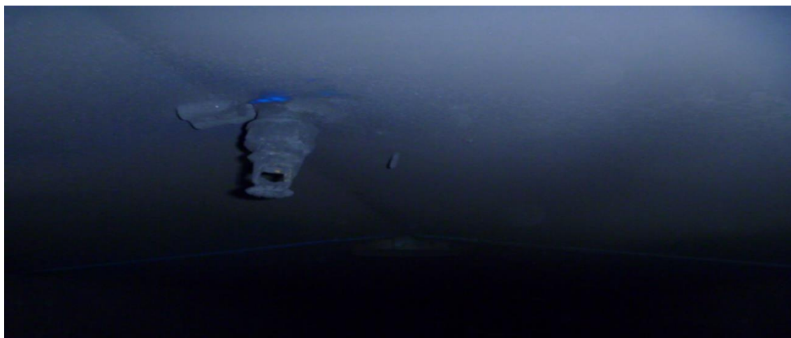
Рисунок 2.11 – Форсуночная система пылеподавления в перегрузочных бункерах 4. Аспирация организованных источников пыления (НДТ В-4).
