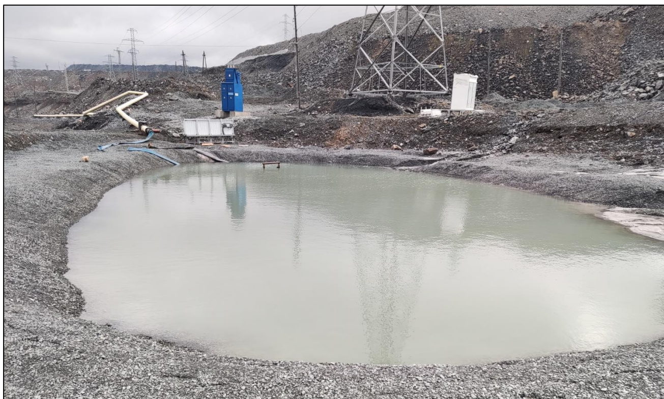
Рисунок 9.1- Водосборник ВК-4 на гор.+710 м юго-восточного борта участка «Восточный» карьера
