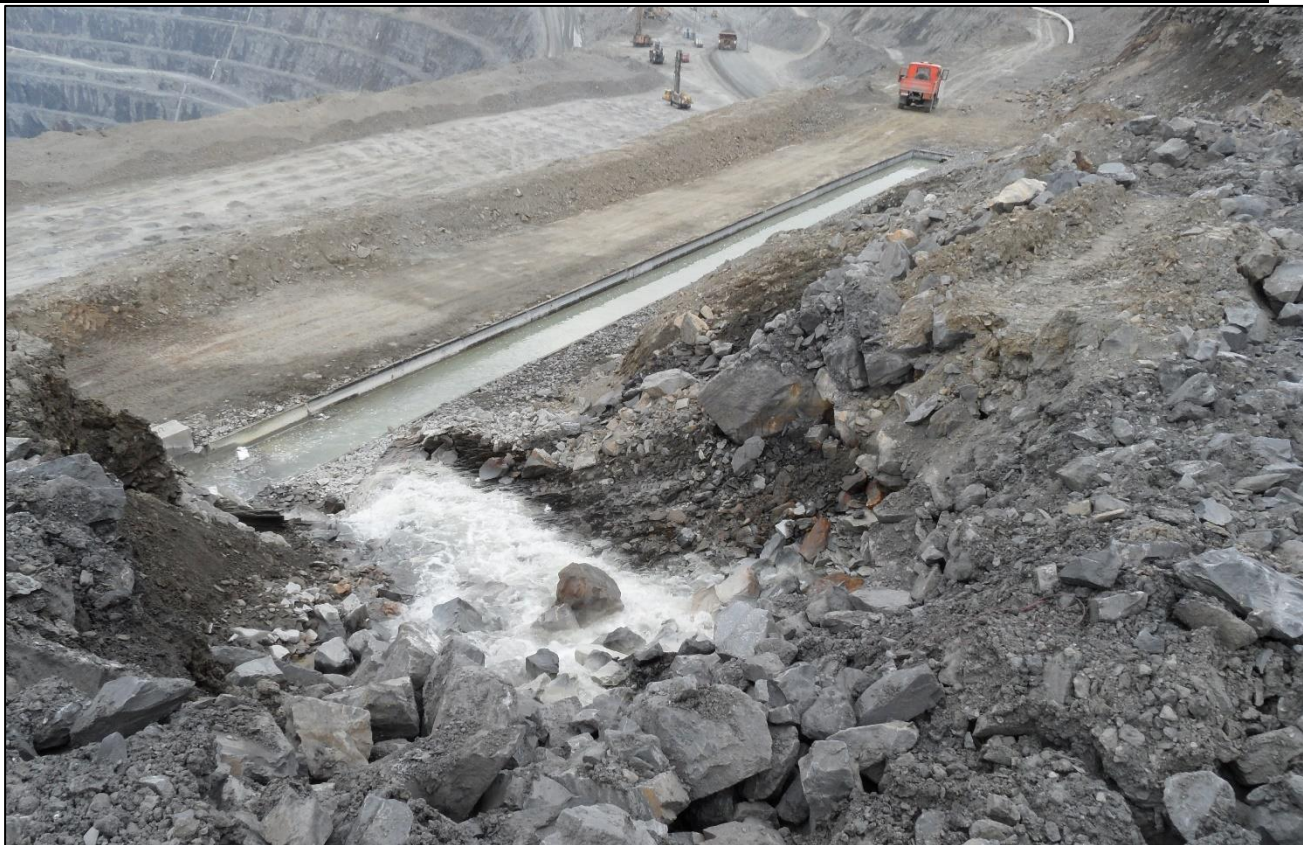
Рисунок 9.2- Общий вид сооружений системы сбора и отведения сточных вод отвала «Восточный» (вид сверху)
