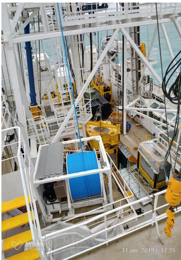
Рисунок 3.6-3. Общий вид буровой установки на судне
