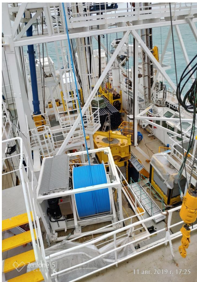
Рисунок 1.3-3. Общий вид буровой установки на судне
