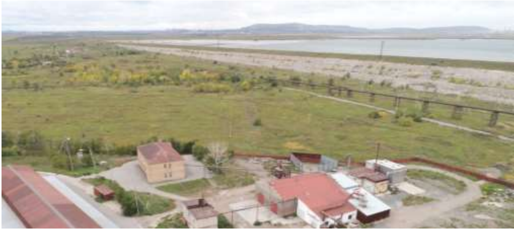
Рисунок 1.1.6 – Вид на шламохранилище № 2
