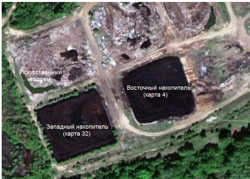
Рисунок 7.4.1 – Накопители с жидкими отходами и искусственный водоем
