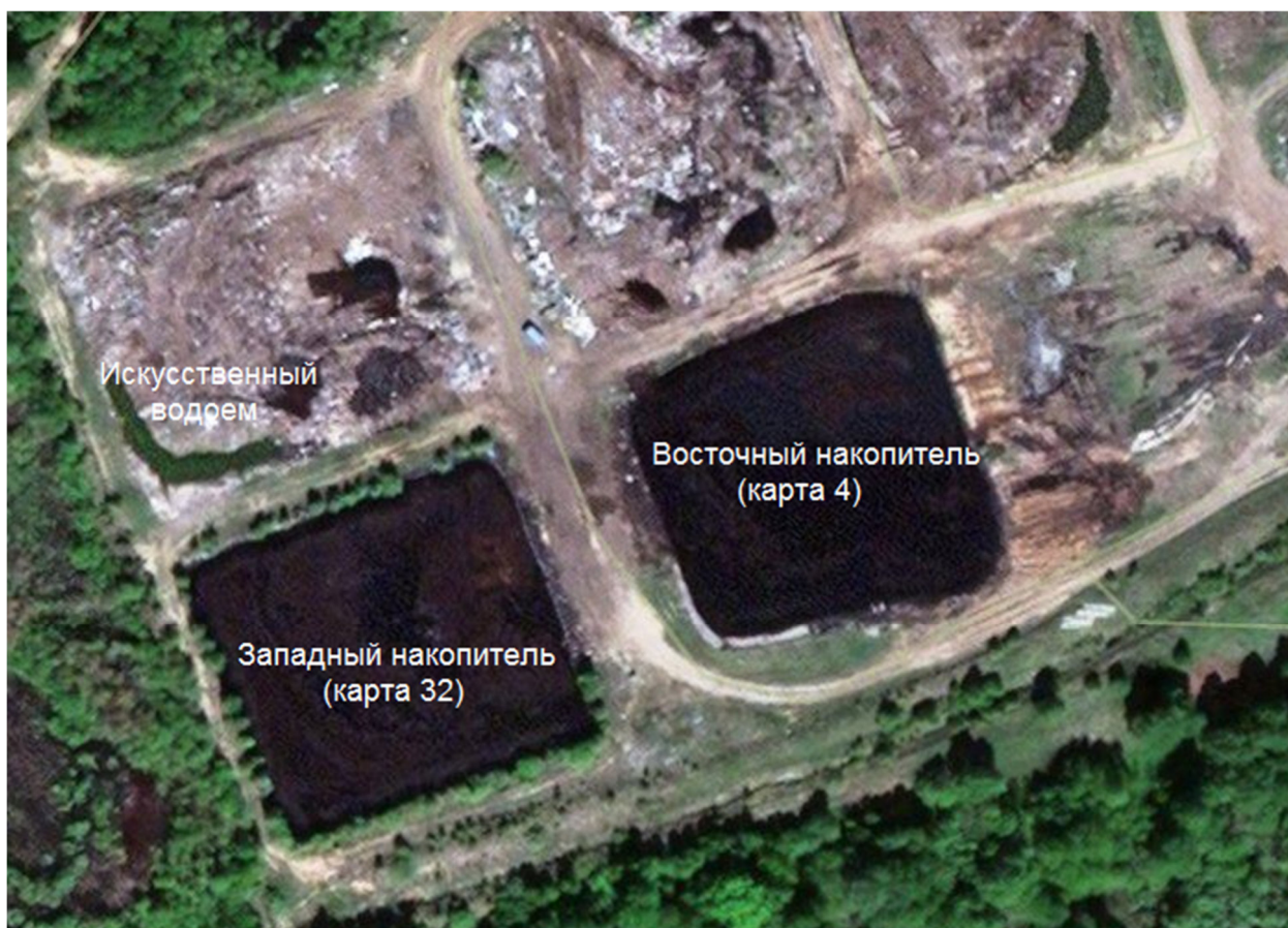
Рисунок 4.2.1 – Накопители с жидкими отходами и искусственный водоем
