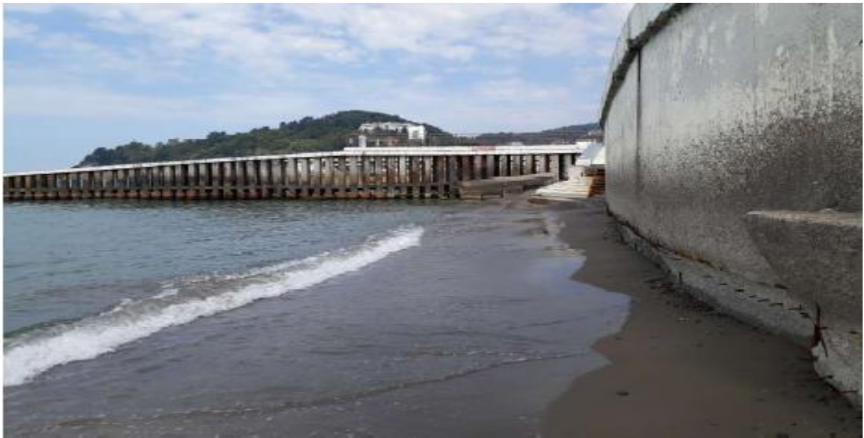
Рисунок 1.4 Подмыв волноотбойной стенки
