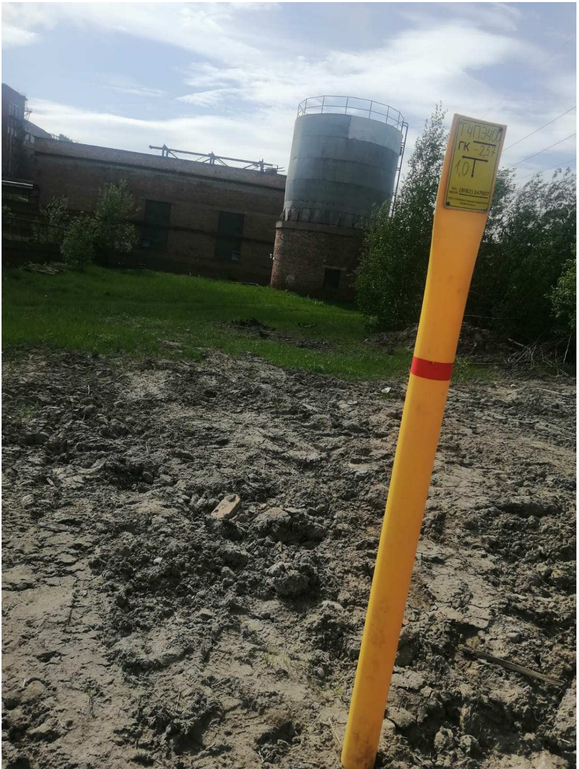
Площадка под строительство ГРП
