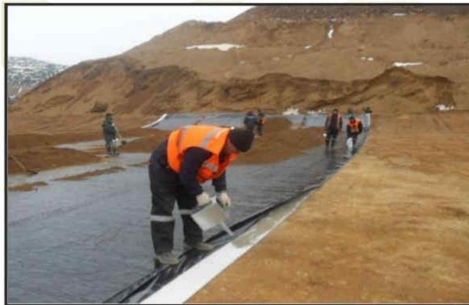
Рис. 4. Просыпка зоны нахлеста бентонитовыми гранулами
