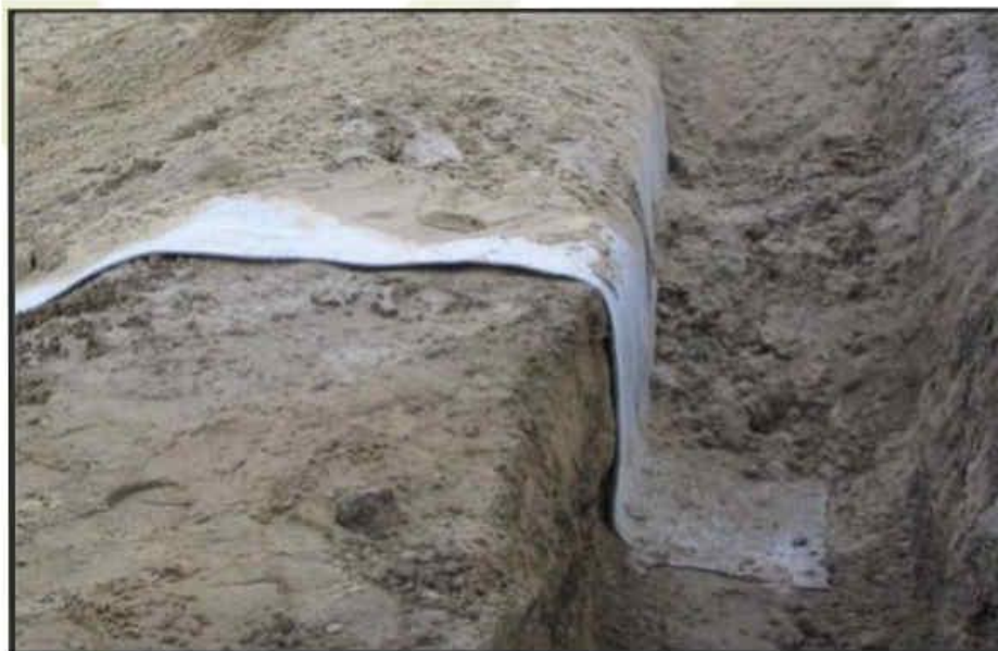
Рис. 2 Устройство анкерного замка
