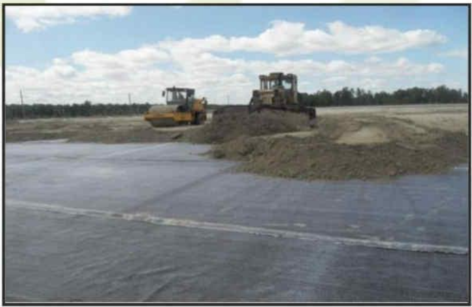
Рис. 6 Устройство обратной засыпки
