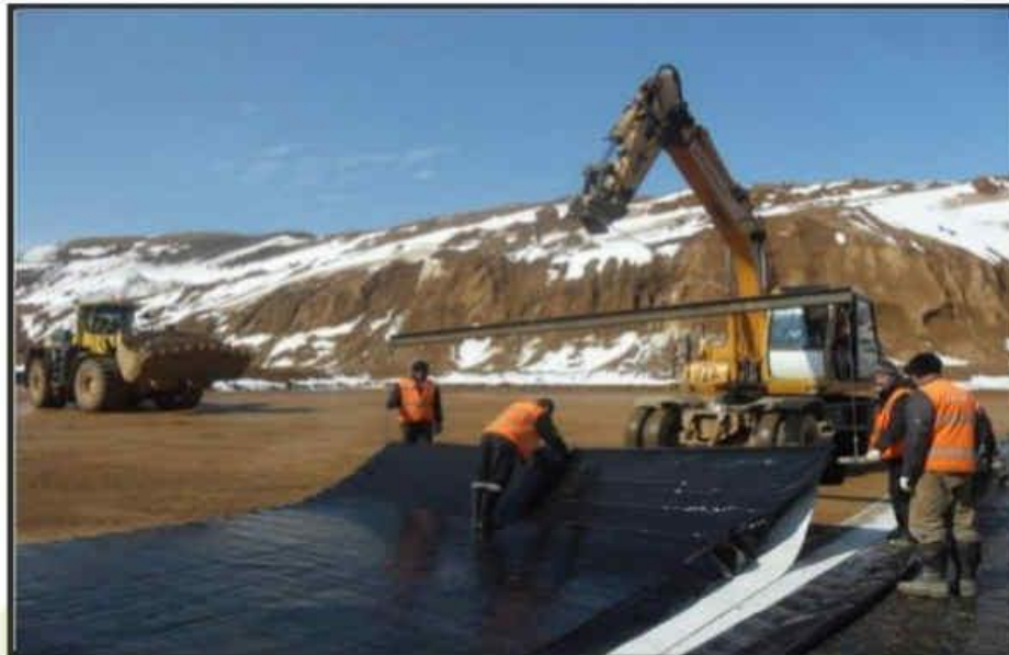
Рис. 3 Укладка бентонитового мата
