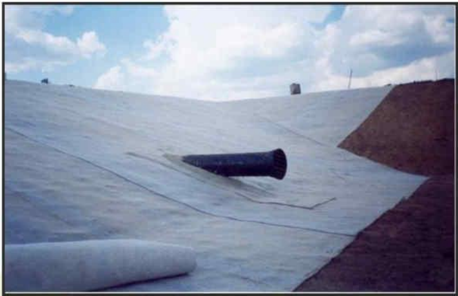
Рис. 5 Экран из бентонитового мата в зоне прохода инженерной коммуникации
