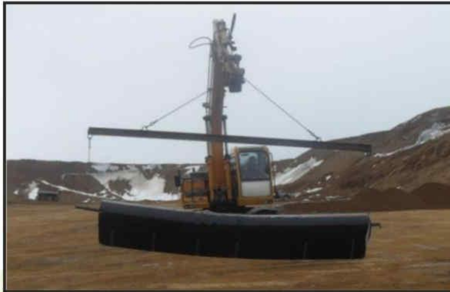
Рис. 1 Траверса для транспортировки и укладки рулонов бенгонитового мата
