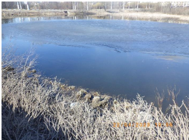
Вид на водопропускную трубу
