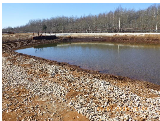
Вид на водопропускное сооружение между прудами
