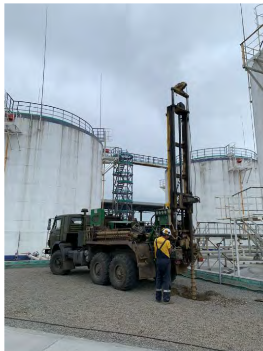
Фото 6. Бурение скважины № 1140
