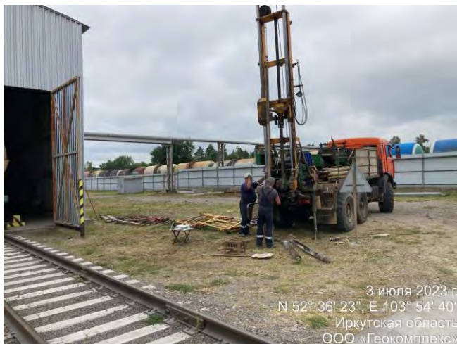
Фото 3. Бурение скважины № 1135
