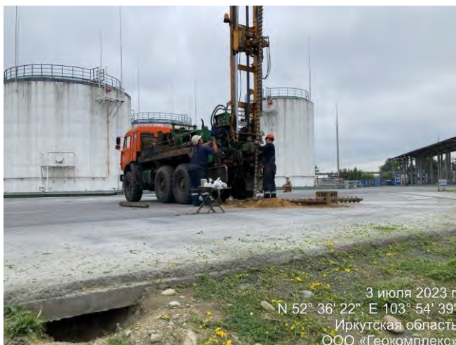
Фото 4. Бурение скважины № 1138
