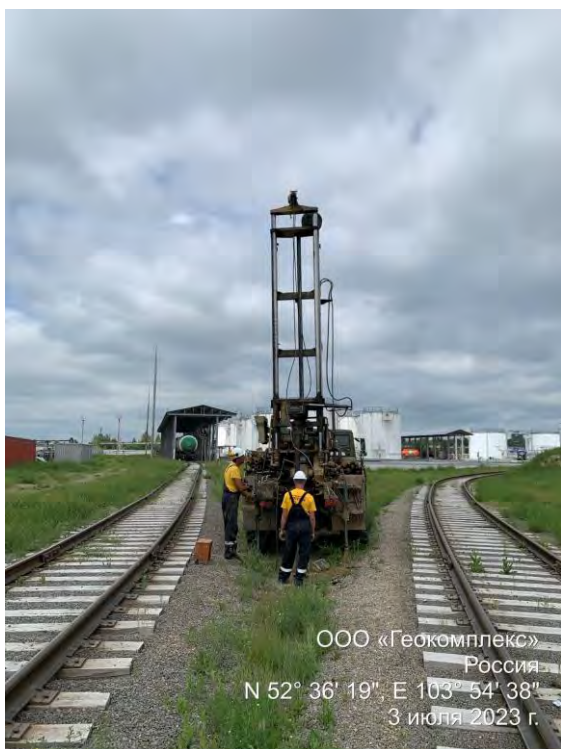
Фото 1. Бурение скважины № 1133
