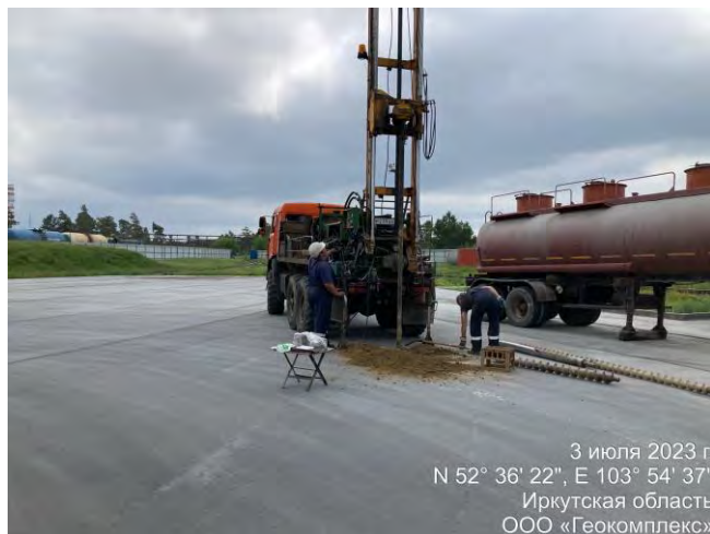
Фото 4. Бурение скважины № 1136
