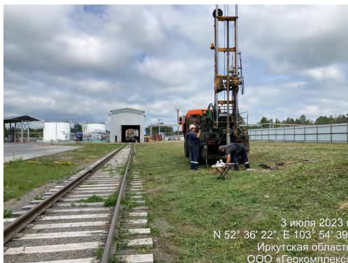
Фото 2. Бурение скважины № 1134
