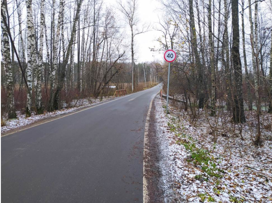
Точка съёмки № 40. Вид в Южном направлении. Фото Шамшин А.А.
