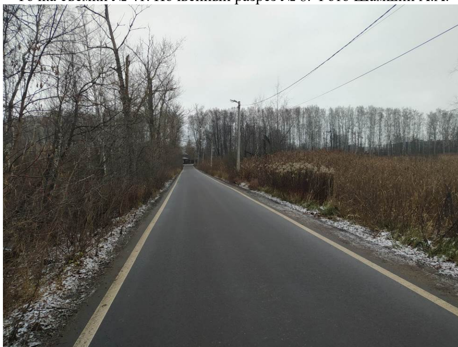
Точка съёмки № 42. Вид в Северном направлении. Фото Шамшин А.А.
