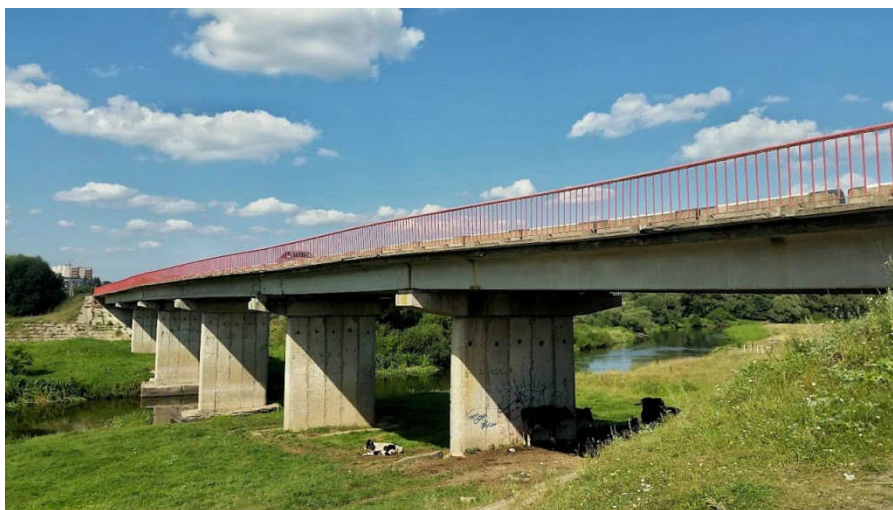
Рис.4.9. Автомобильный мост через р. Протва у г. Кременки, как потенциальный источник загрязнения
