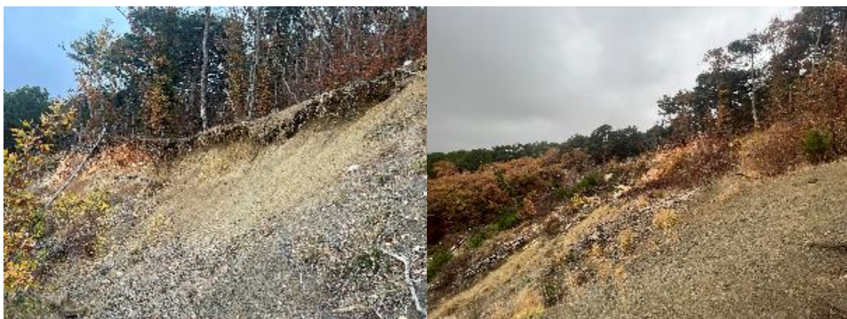
Рис.5.2.1.6. Оползень в 50 м от полигона
