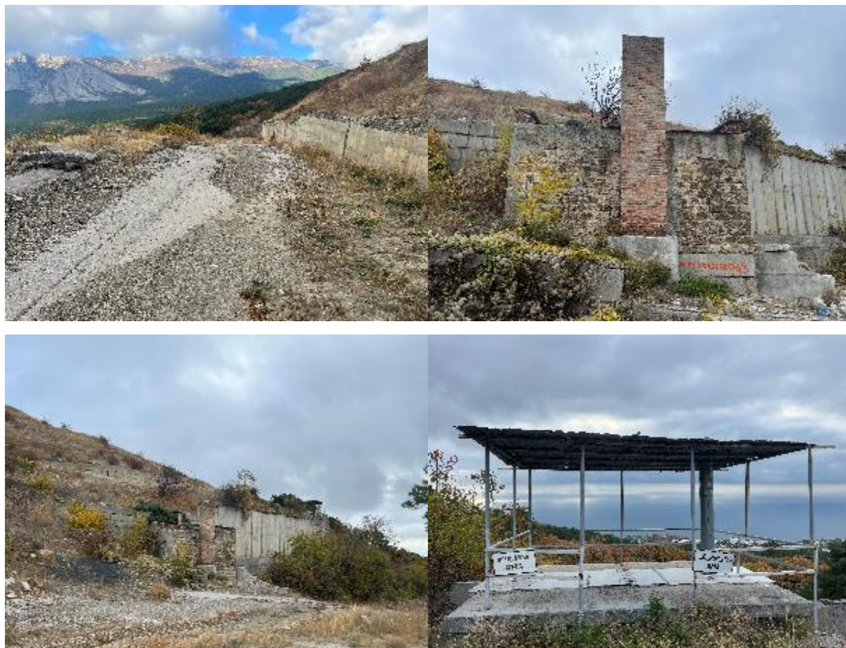
Рис.5.2.1.3. Полигон и строения на его территории
