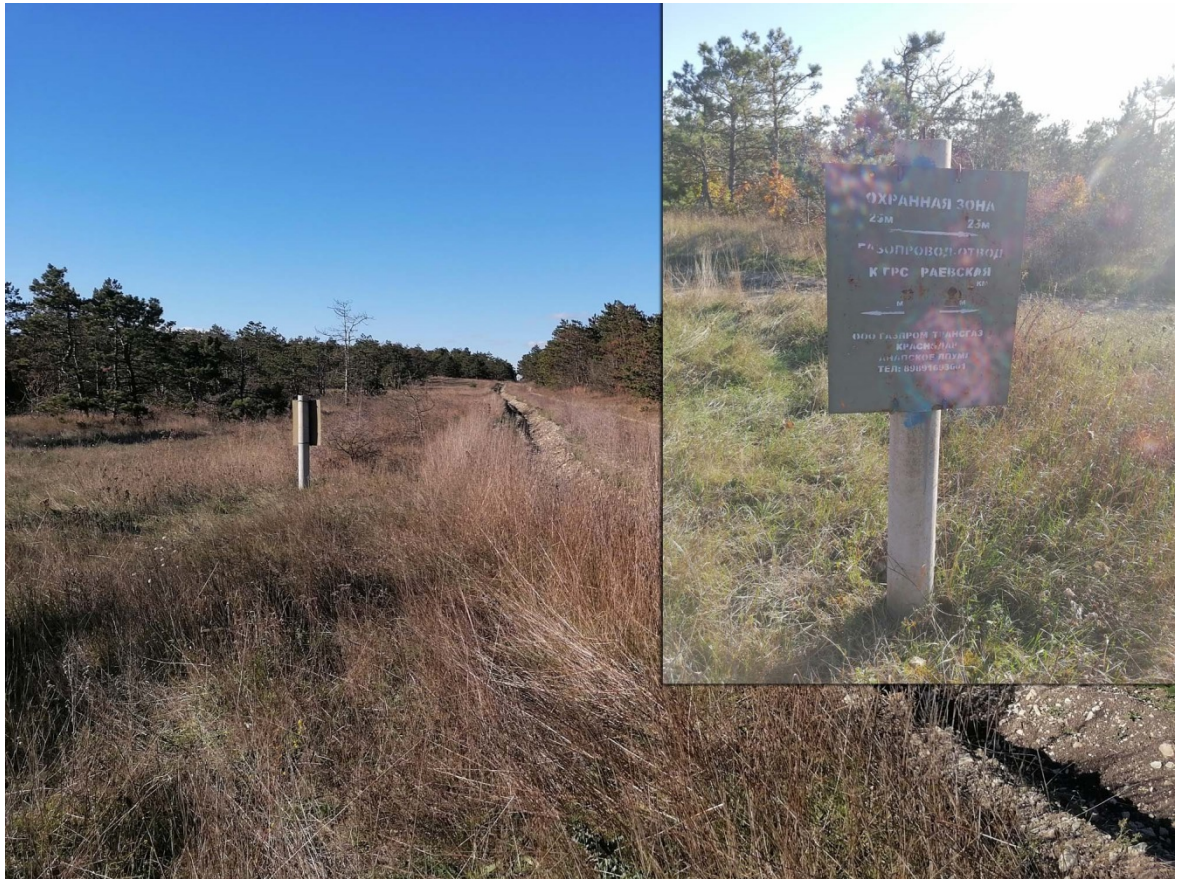
Рис. 18. Просека газопровода-отвода к ГРС "Раевская" в северном кластере Фото: Антонов О.М. 01.11.2022г.
