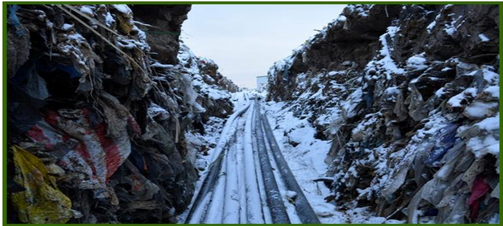
Рис. 20. Газосборные трубопроводы в траншее
