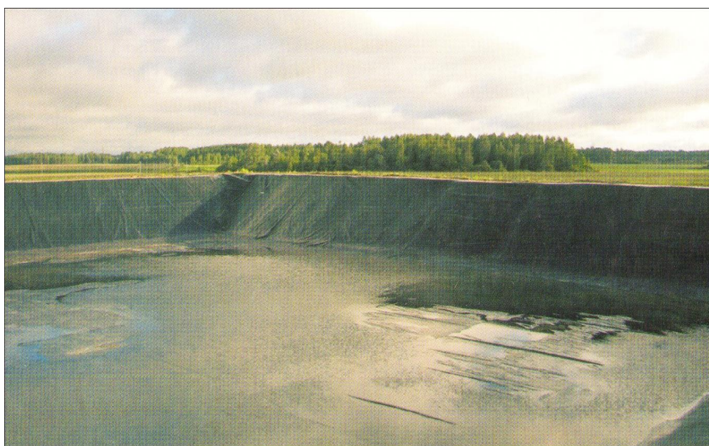
Рис. 8. Внешний вид внутренней гидроизоляции пруда-накопителя (пример).
