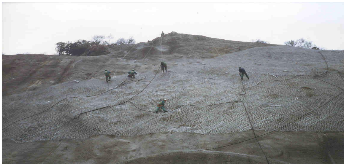
Рис. 25. Пример укрепления откоса
