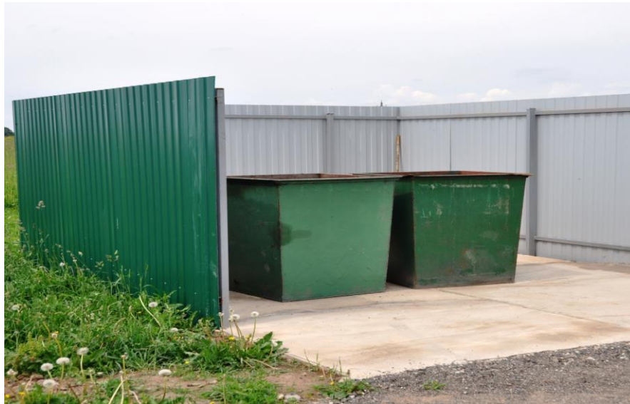
Рис. 7. Площадка для контейнеров.
